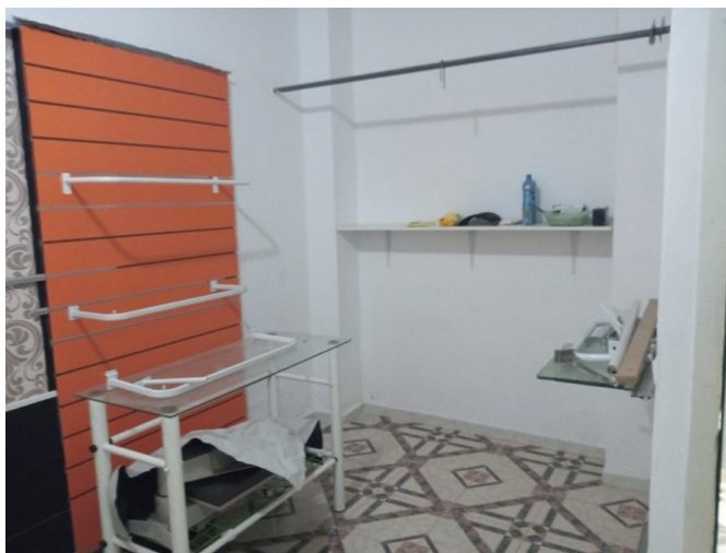
Figura 3. Registro fotográfico del estado actual del local. Fuente propia. 2024
