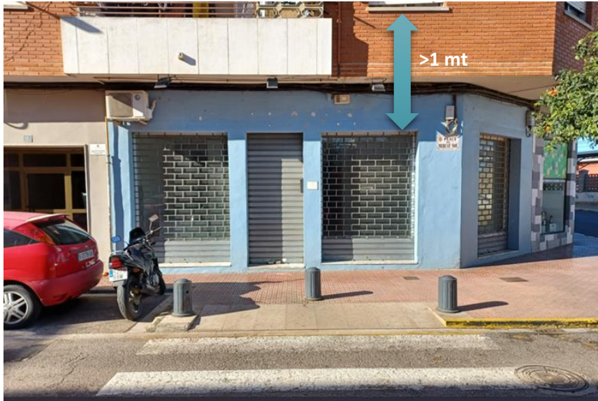
Figura 25. Justificación propagación de incendio. Fuente propia.2024
