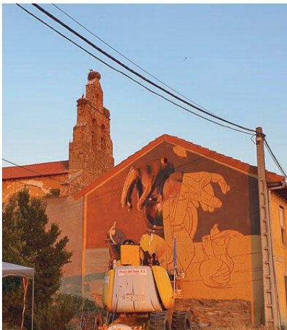
fig.7. InterBenavente. Intervención en un muro de La Torre del Valle, Zamora . Arte contra el olvido. 2022.
