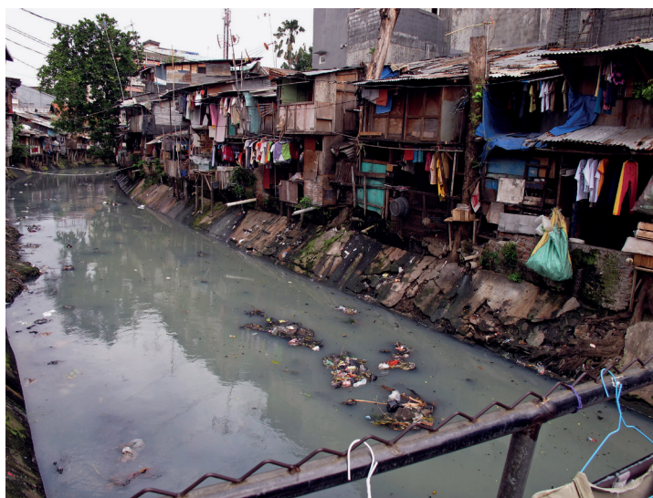
Figura 21.4. Canal de drenaje de Yakarta, con vertidos directos desde los hogares. Fuente: Farhana Asnap/World Bank (Water Alternatives Photos, Flickr).
