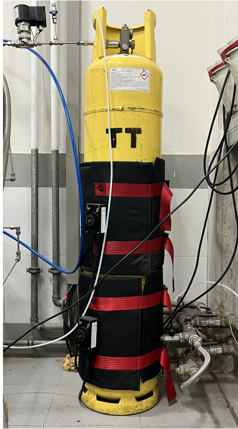
Figura 3.18. Depósito NH_3
