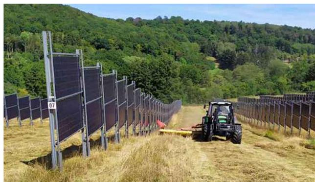
Ilustración 12- Ejemplo de paneles verticales de la empresa Next2Sun
