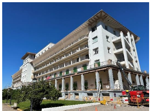
Fig. 45. Fotografies actuals de les obres de la façana de l'hospital.
