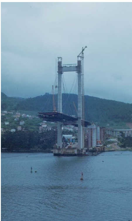
Fig. 88. Puente de Rande en construcción.
