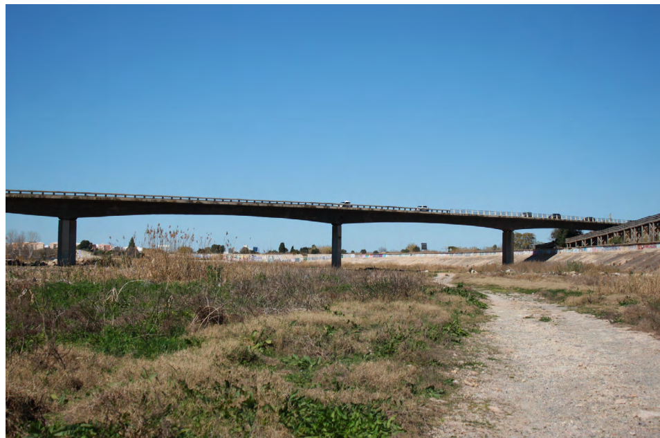
Img. 12. Puente de tráfico sobre el nuevo cauce del Turia. Foto de autoría propia.
