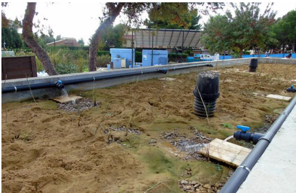
Figura 26. Humedal de flujo subsuperficial modelado en este TFM al inicio del proyecto.
