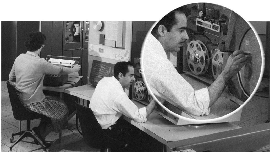
*Figura 32. Sección de monitor y lápiz óptico del PDP-1 (1961). Fuente: Lawrence Livermore National Laboratory, cuenta en Flickr.*
