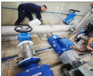
Figura 7. Extracción de lodos de potabilizadora.
