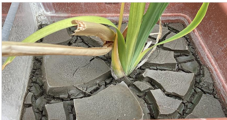
Figura 24. Acumulación de lodos en las grietas en H-2
