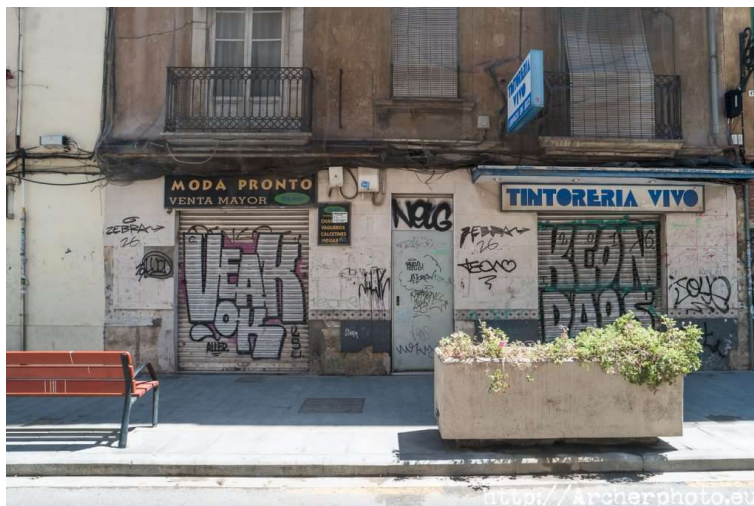
Dato: Fachadas del barrio de Ruzafá en los primeros años de gentrificación del barrio.
