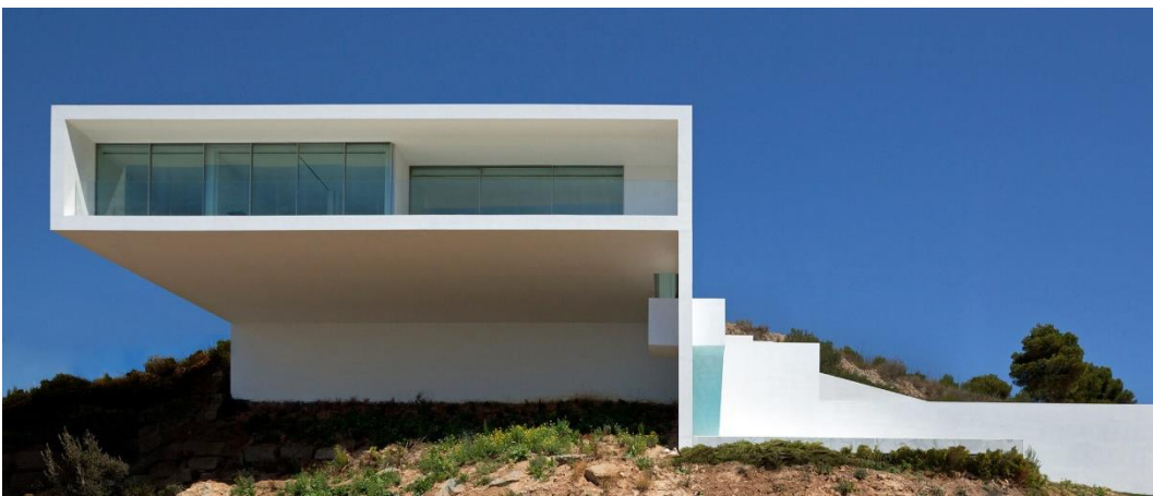
Figura 03.03-02. Fotografía Casa del Acantilado: Fachada sureste. Fuente: Fran Silvestre Arquitectos.
