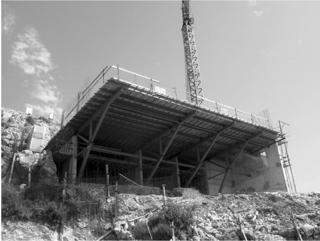
Figura 03.02-07. Fotografía fase de ejecución: Cimbra completa. Fuente: Estructuras Singulares.
