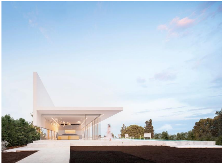
Figura 02.02-02. Fotografía Casa Hofmann. Fuente: Fran Silvestre Arquitectos.
