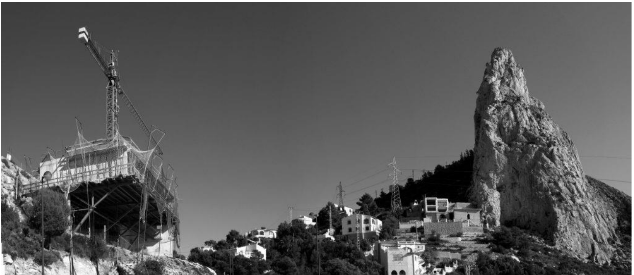
Figura 03.02-08. Fotografía fase de ejecución: Construcción vivienda. Fuente: Estructuras Singulares.
