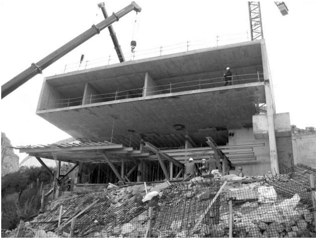
Figura 03.02-11. Fotografía fase de ejecución: Descimbrado 03. Fuente: Estructuras Singulares.
