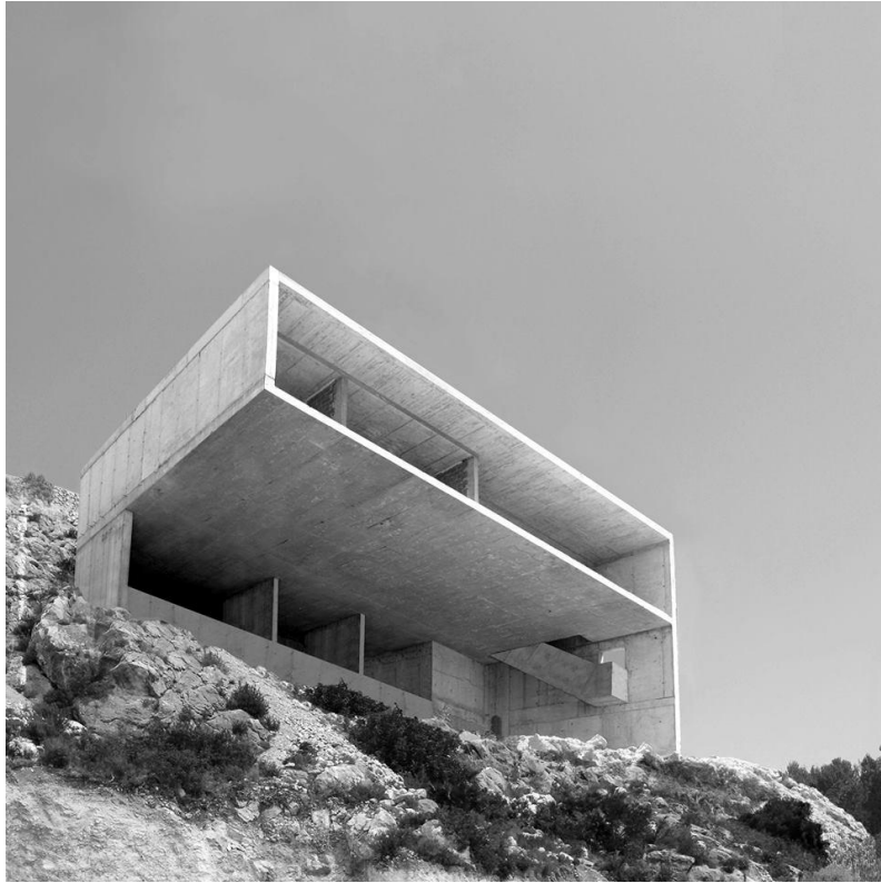
Figura 03.02-13. Fotografía fase de ejecución: Estructura completada 02. Fuente: Estructuras Singulares.
