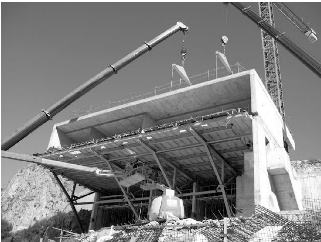
Figura 03.02-10. Fotografía fase de ejecución: Descimbrado 02. Fuente: Estructuras Singulares.
