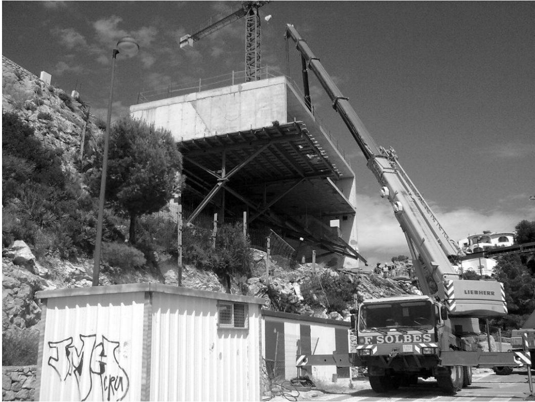
Figura 03.02-09. Fotografía fase de ejecución: Descimbrado 01. Fuente: Estructuras Singulares.
