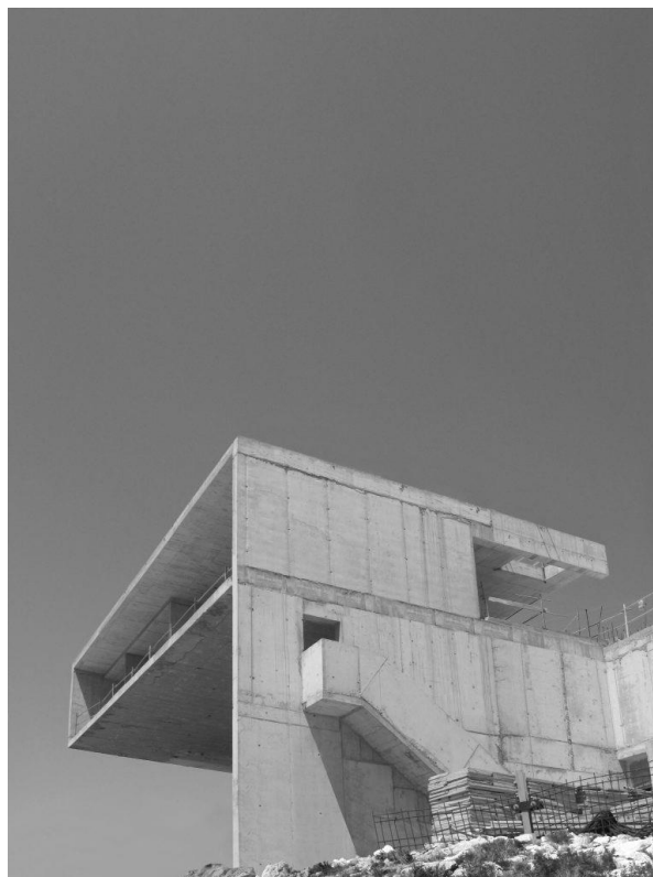
Figura 03.02-12. Fotografía fase de ejecución: Estructura completada 01. Fuente: Estructuras Singulares.
