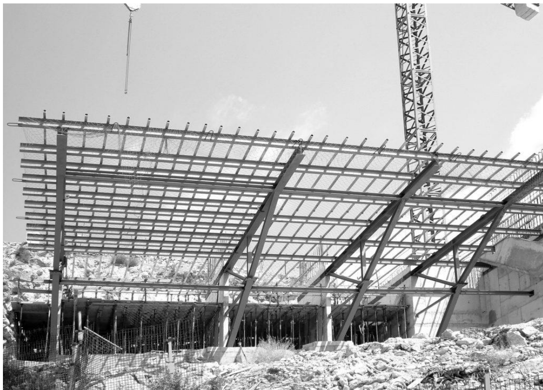
Figura 03.02-06. Fotografía fase de ejecución: Construcción cimbra. Fuente: Estructuras Singulares.
