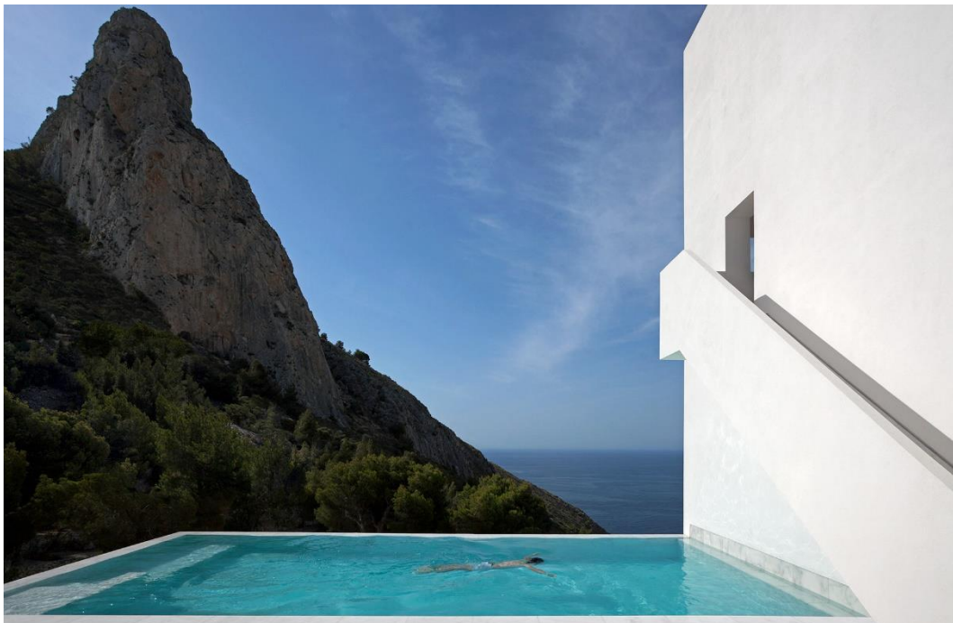
Figura 03.03-07. Fotografía Casa del Acantilado: Plataforma piscina. Fuente: Fran Silvestre Arquitectos.
