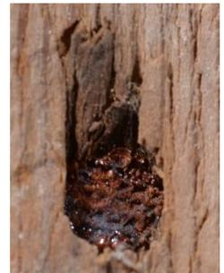
**Figura 81.** Detalle de clavo oxidado con astillamiento de la madera.
