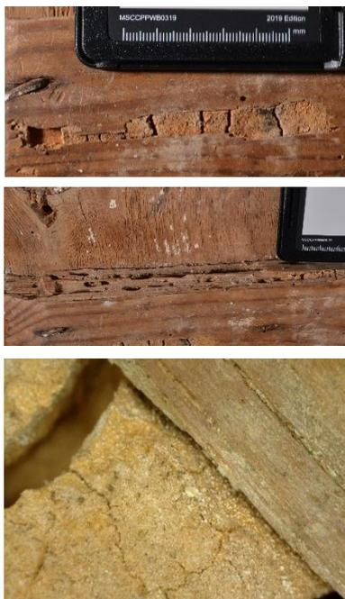
**Figura 69.** Detalle del ataque de *Hylotrupes bajulus* L.
