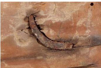
Figura 48. Detalle del clavo plegado y reintroducido.
