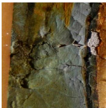
**Figura 93.** Detalle de zona deformada por hinchazón del clavo oxidado.
