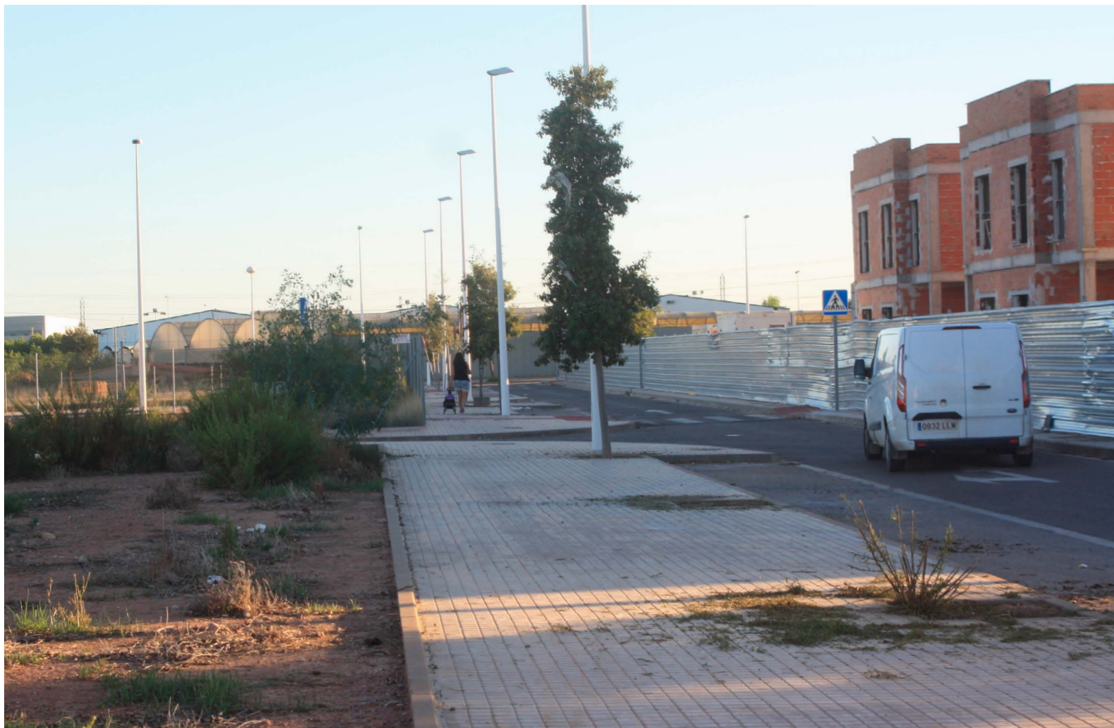
2023 PAI FUSIÓN, Sagunto - fotografía propia
