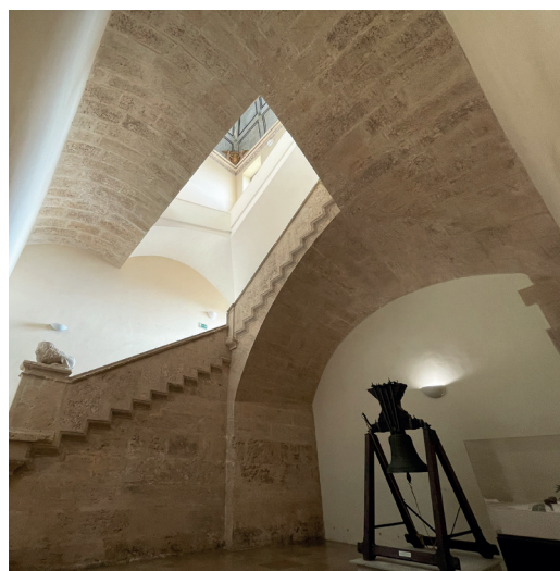
Figura 16. Hipótesis de traza de la escalera del Real Colegio de Corpus Christi, en Valencia (1599). Marín y López (2018)
