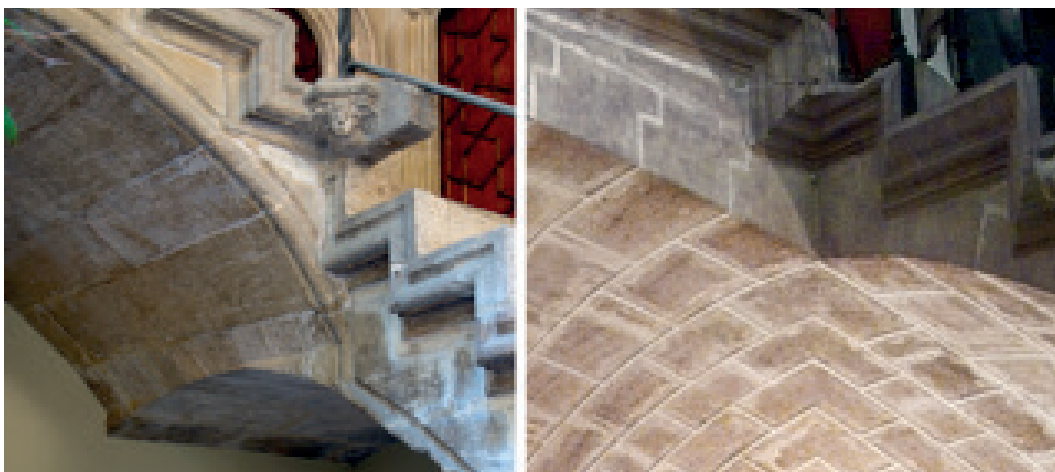
Figura 3. Comparativa entre el encuentro de las bóvedas bajo las mesetas de la escalera del Palau de la Scala (inicio del s. XVI), en Valencia y de santo Domingo de Orihuela (1566-1568)
