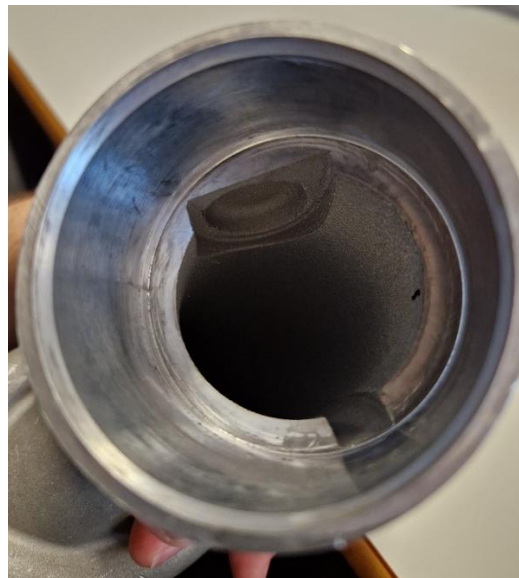
Figura 5.41. Conducto principal del aire limpio del compresor
