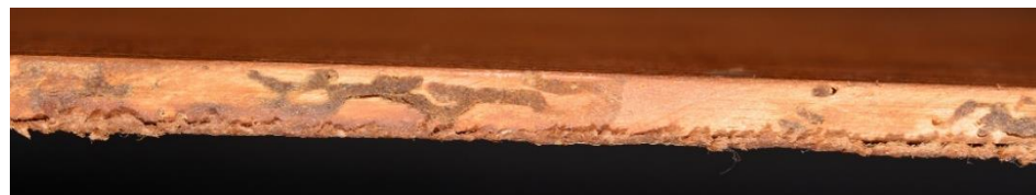
Fotografía 43: Fotografía detalle 2 de galería realizada por ataque de Anobium punctatum . (con estuco)
