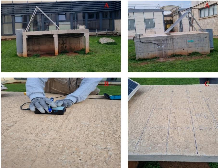
Figura 3. 14. Intervención en estructura real. A. Estructura antes de la intervención. B. Identificación de armaduras. C. Cuadrícula de armaduras identificadas.
