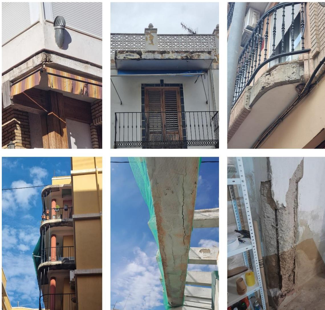
Figura 2. 1. Ejemplo de problemas de corrosión en edificios
