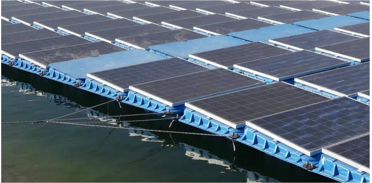
Figura 7. Ejemplo de instalación flotante a 5° de inclinación. (isifloating.com)
