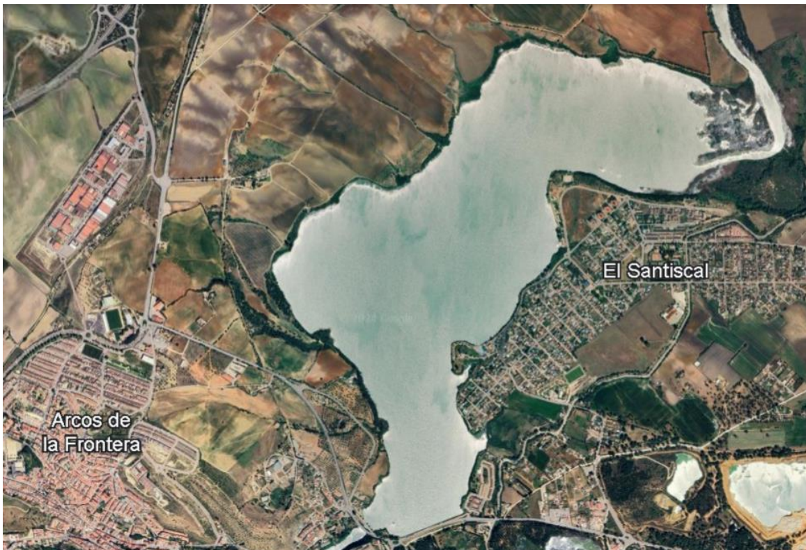
Figura 2. Vista satélite del emplazamiento, detalle de la presa. (Google Earth)
