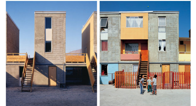
Fig. 51 | Vivienda social adaptable que incorpora la construcción por fases para posibles ampliaciones.
