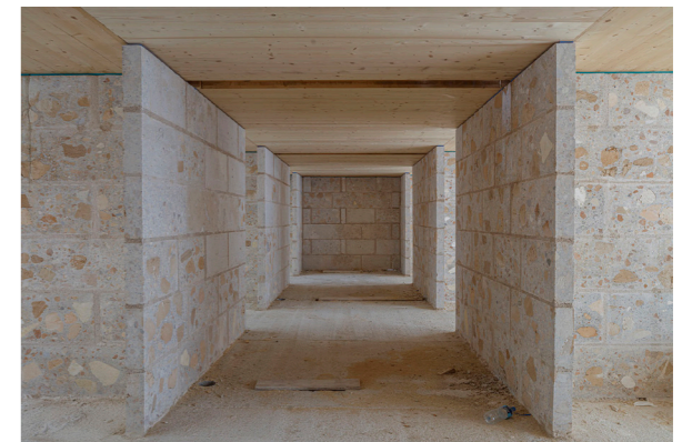
Fig. 17 | Aprovechamiento de la materia del edificio preexistente para la construcción del nuevo edificio.
