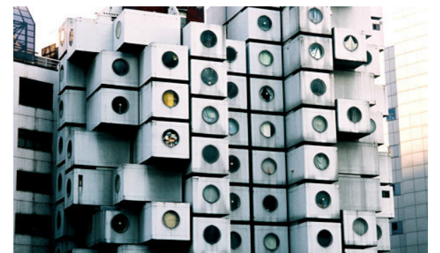
Fig. 53 | Adaptabilidad a través de la modulación y la prefabricación de piezas sustituibles.
