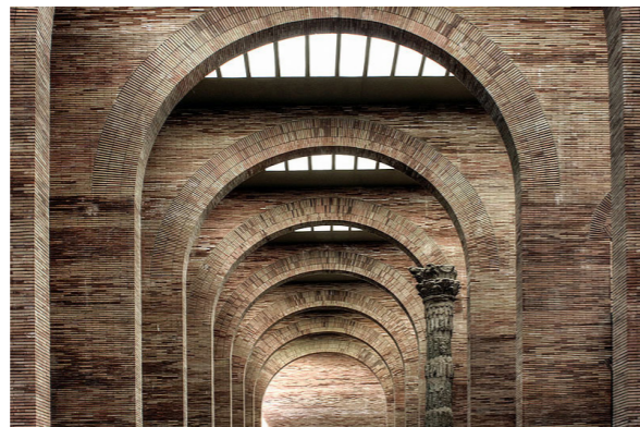
Fig. 84 | Ritmo definido por la modulación estructural generando focos de luz difusa.
