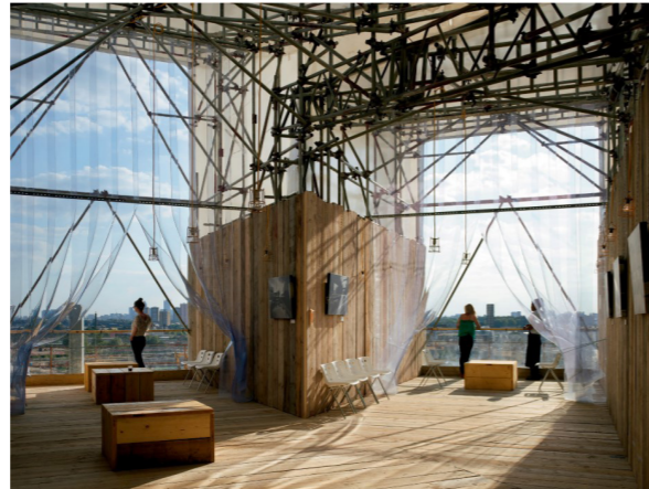
Fig. 31 | Pabellón efímero construido reaprovechando materiales auxiliares de una obra próxima.
