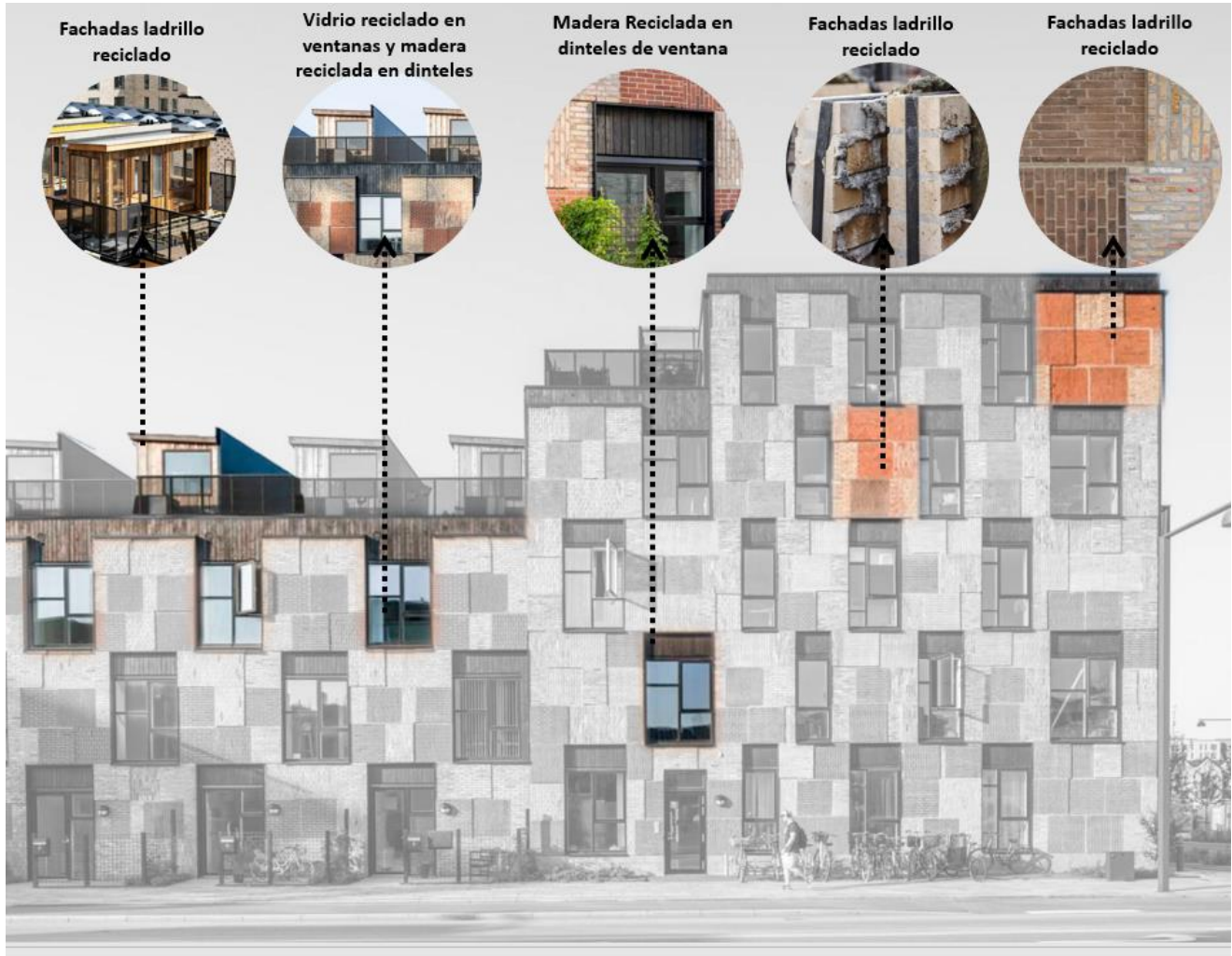
Fig. 48. Materiales reciclados en fachada exterior en Resource Rows (Re elaboración propia,2024) Fuente (Lendager y Pedersen,2020)
