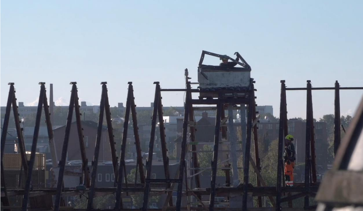
Fig. 137. Proceso de construcción de cerchas. Fuente (Lendager y Petersen, 2020)
