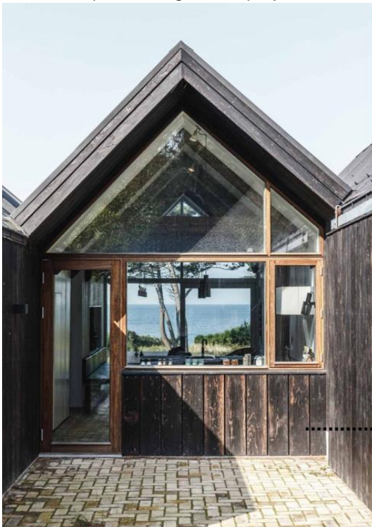
Fig. 75. Material reciclado en fachada exterior (Re elaboración propia,2024) Fuente: https://lendager.com/project/waste-retreat/
