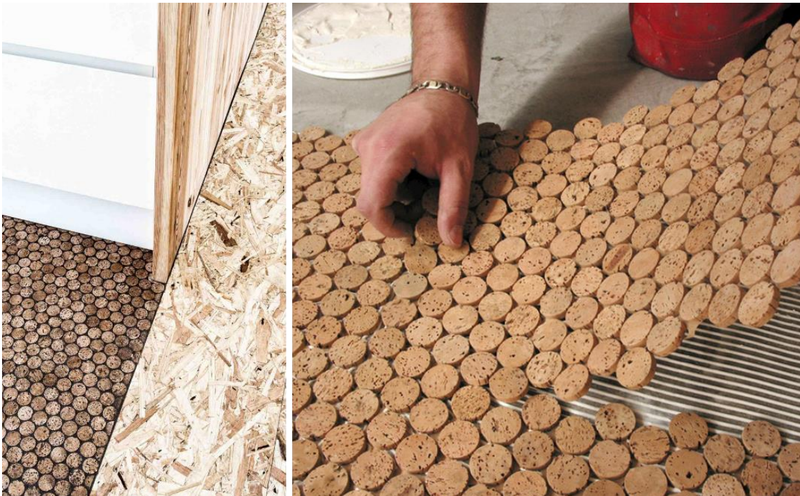
Fig. 90. Suelo de cocina con corcho reciclado (Lendager,2013) Fuente: https://lendager.com/project/upcycle-house/
