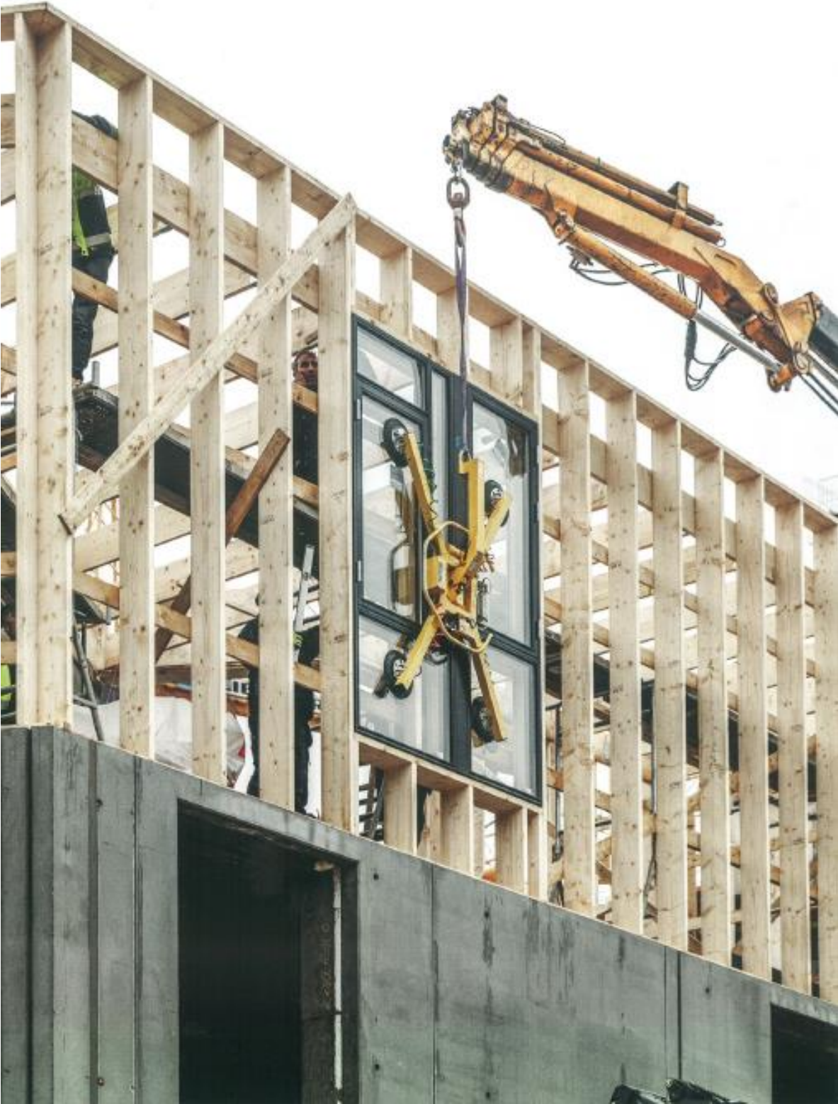
Fig. 111. Proceso de construcción en madera y montaje ventana reciclada (Lendager,2018)
