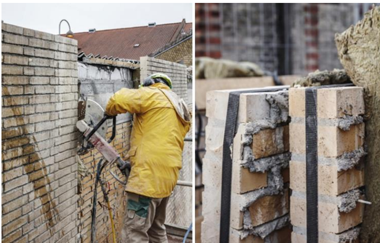
Fig. 26. Proceso de cortado de Módulos de ladrillo (Lendager, 2021) Fuente: https://lendager.com/project/resource-rows/
