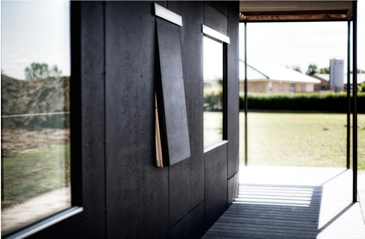
Fig. 89. Fachada con láminas de madera (Archdaily,2013) Fuente: https://www.archdaily.cl/cl/02-319717/casa-upcycle-lendager-arkitekter
