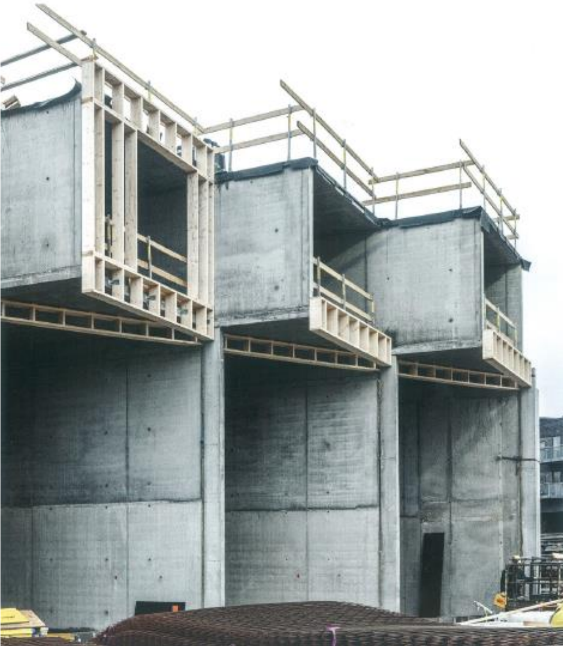
Fig. 112. Proceso de construcción con madera y hormigón reciclado Fuente (Lendager y Pedersen,2020)
