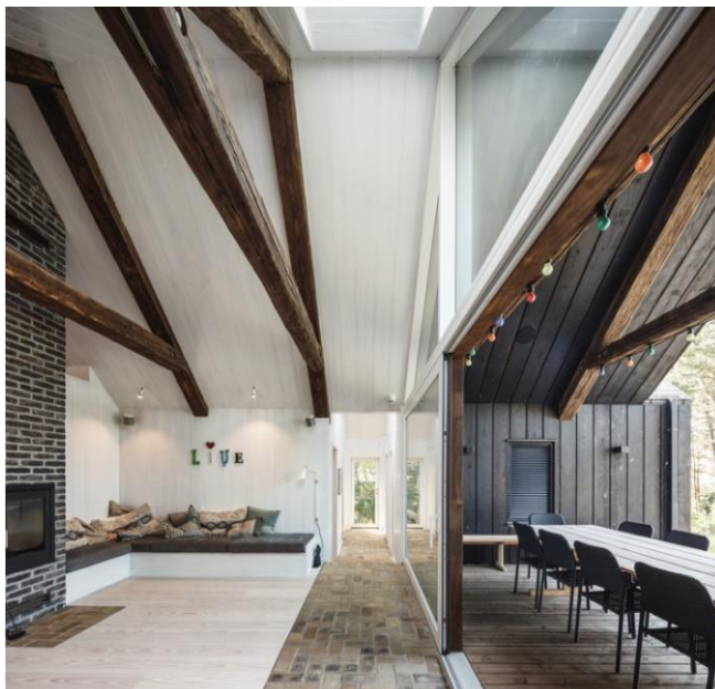
Fig. 71. Madera reciclada en interior y exterior (Lendager, 2018)
