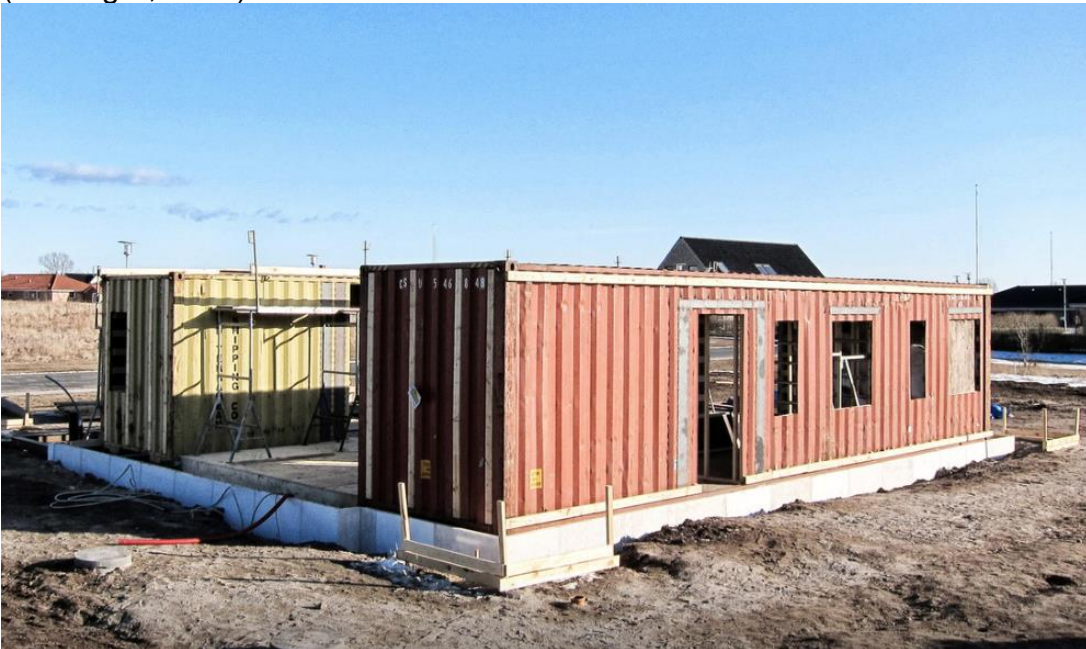
Fig. 86. Estructura con contenedores marítimos (Lendager,2013)
