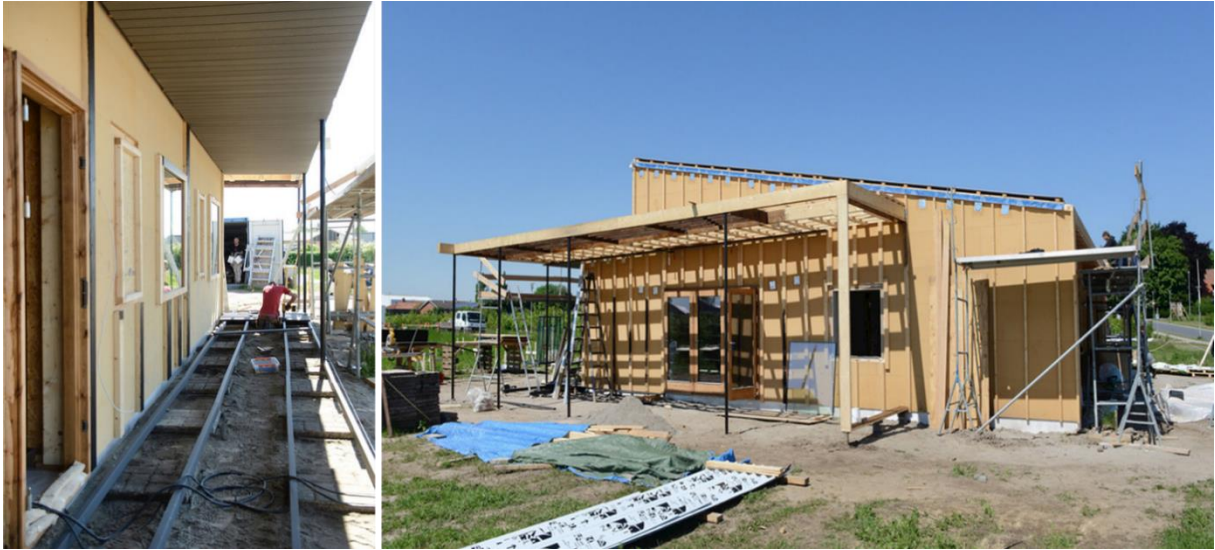
Fig. 87. Proceso de construcción con madera y vigas metálicas (Lendager,2018) Fuente: https://lendager.com/project/upcycle-house/
