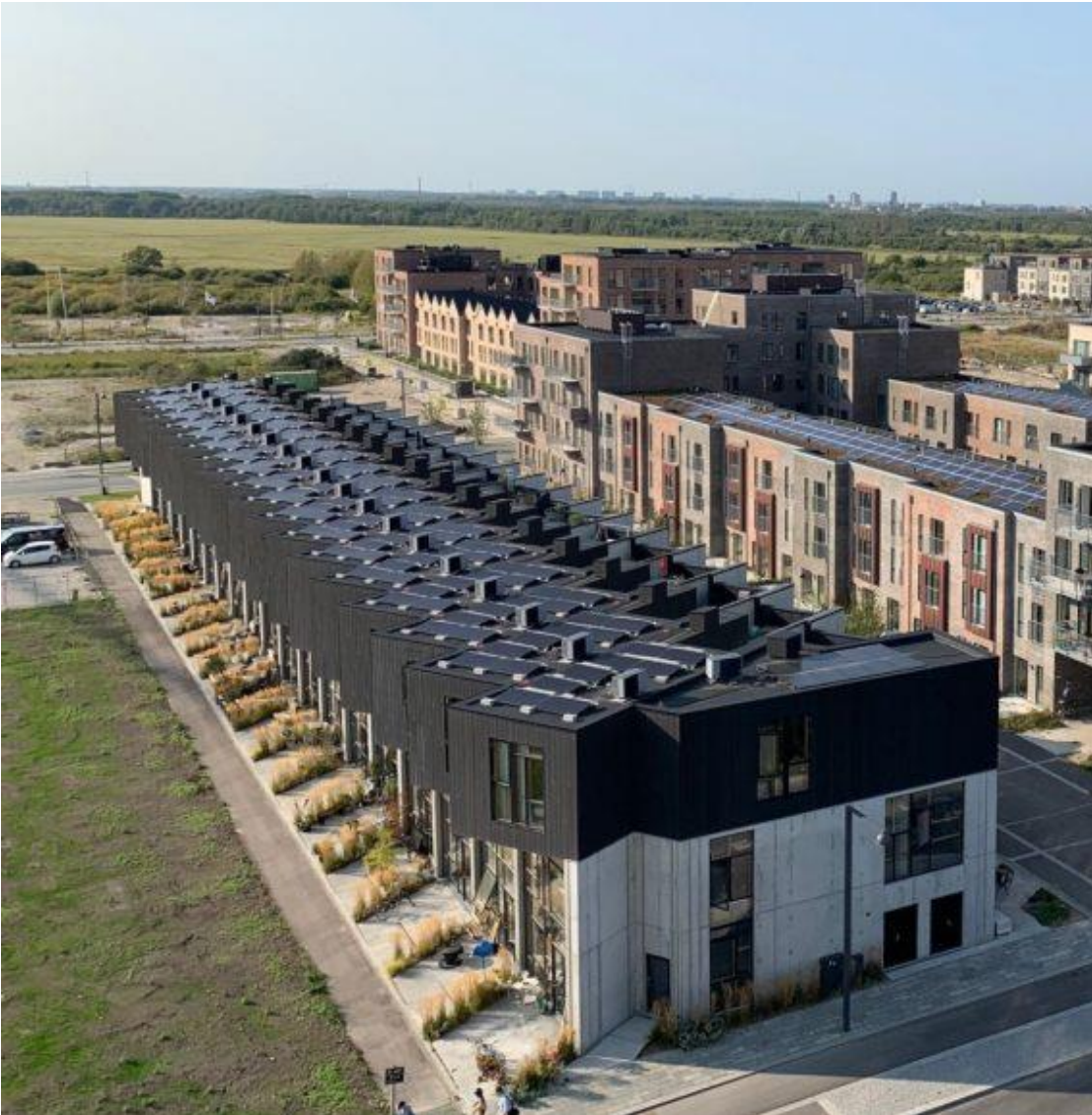
Fig. 101. Vista aérea de fachada exterior (Lendager, 2018)
