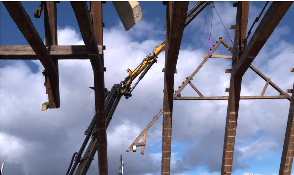
Fig. 138. Proceso de construcción de cerchas. Fuente (Lendager y Petersen ,2021)
