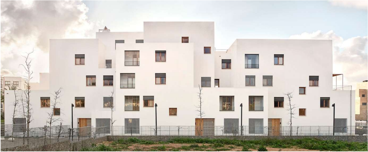
Ilustración 27_Imagen exterior. 43 VPP en Ibiza. Fuente: Peris Toral Arquitectes. Fotografía por Jose Hevia.
