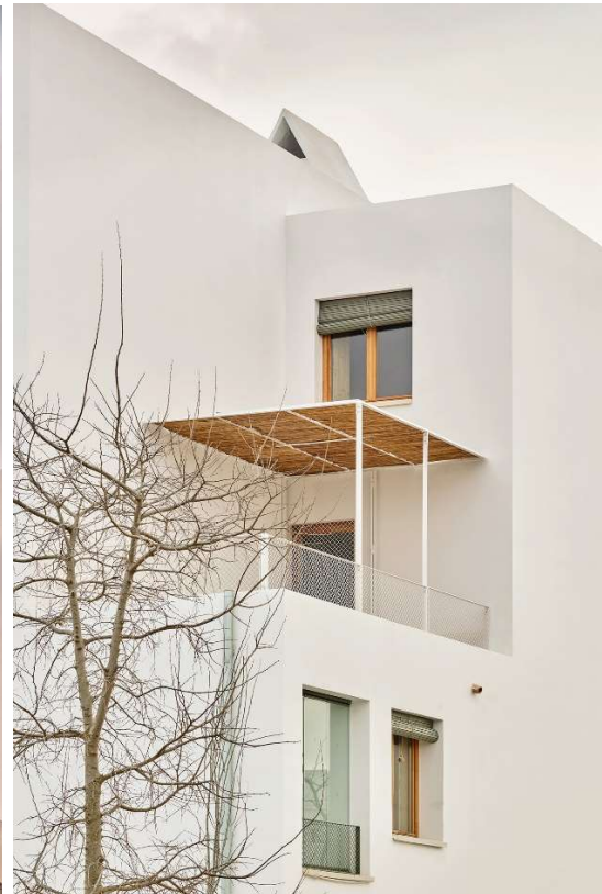
Ilustración 39_Imagen exterior. 43 VPP en Ibiza. Fuente: Peris Toral Arquitectes. Fotografía por Jose Hevia.
