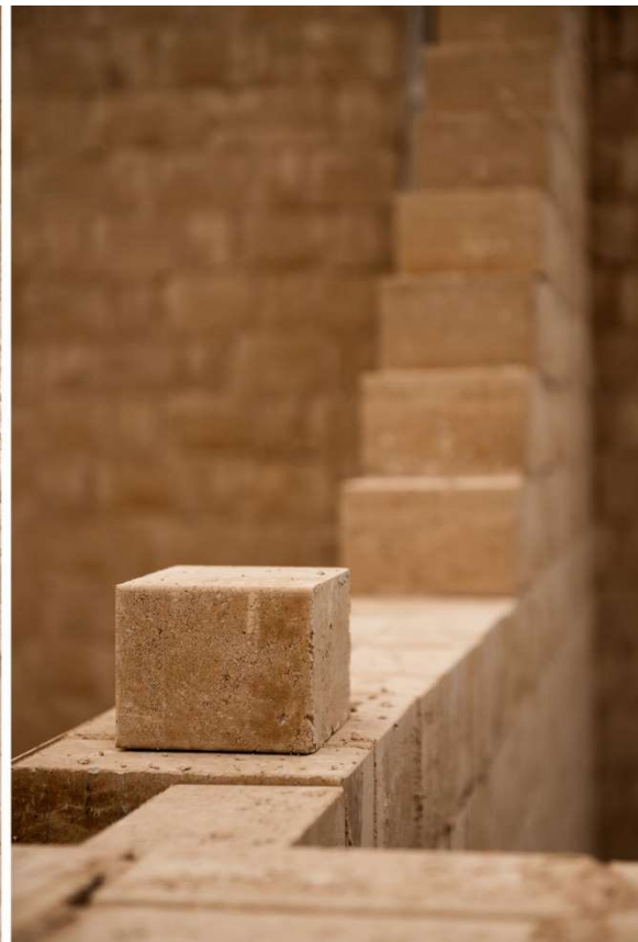
Ilustración 41_Imagen BTC. Fuente: Peris Toral Arquitectes. Fotografía por Jose Hevia.
