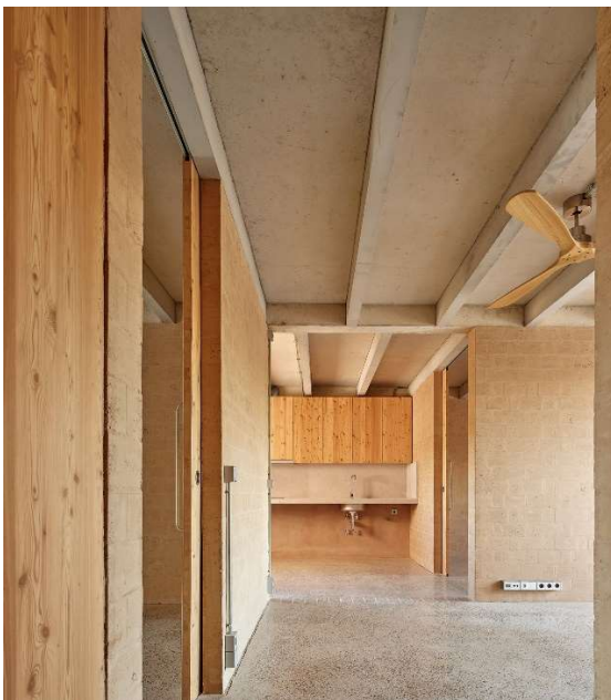
Ilustración 42_Imagen forjado de hormigón. Fuente: Peris Toral Arquitectes. Fotografía por Jose Hevia.
