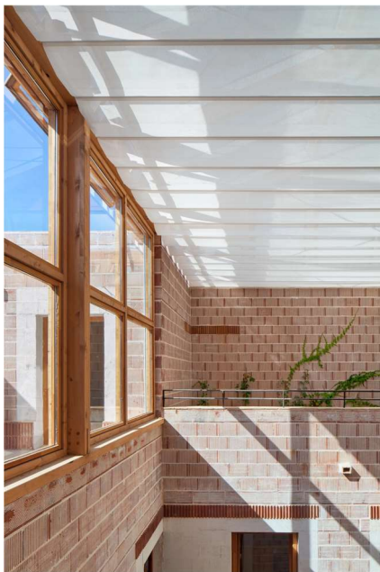
Ilustración 68_Imagen atrio en verano. 24 VPP en Ibiza. Fuente: 08014 Arquitectura. Fotografía por Pol Viladoms.
