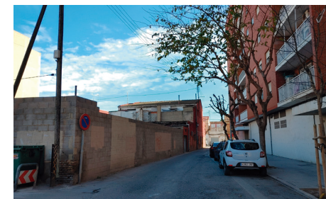
Derribo y nueva ordenación de vivienda frente a las Casitas Rosas
