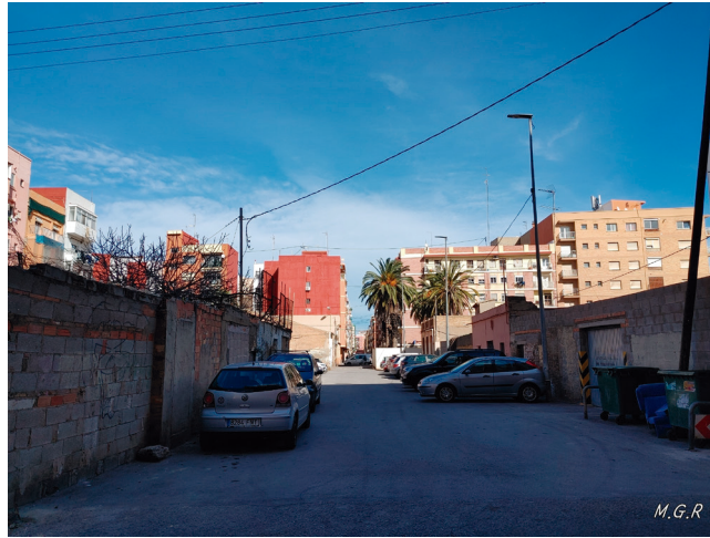
C/ San Rafael, callejón entre plantas bajas muy deterioradas
