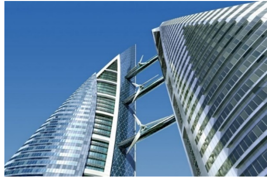
Figura 22. Minieólica integrada en los edificios. Fuente: inarquia
