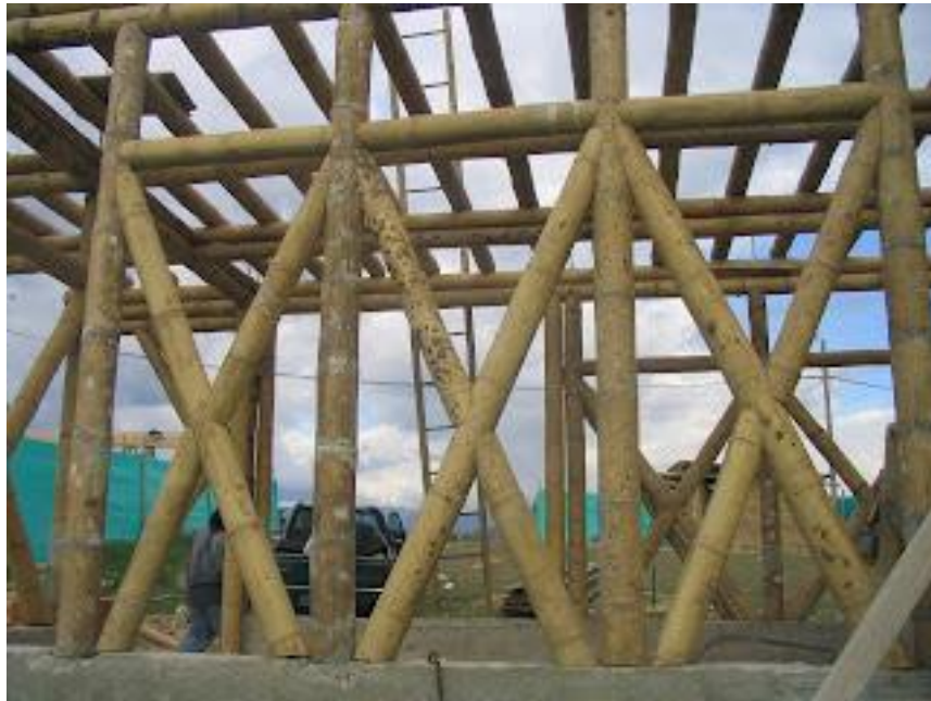
Imagen 104. Estructura de muros en Guadua. Fuente: Ingeniería en Arquitectura y Diseño Medioambiental, 2012
