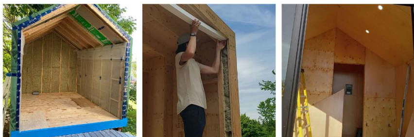
Imagen 36. Aislamiento en fibra de vidrio. Fuente: THE BUNKIE CO, 2024
