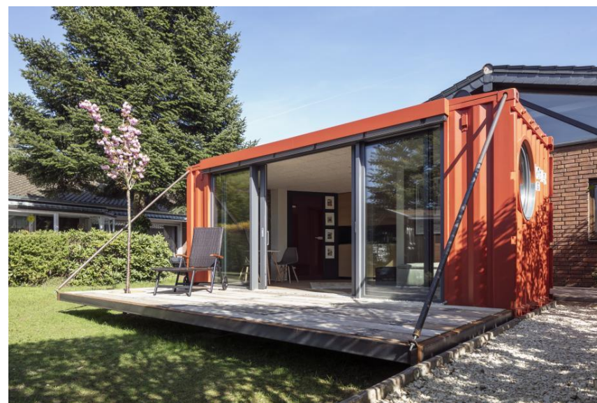
Imagen 33. Contenedor marítimo adaptado para una tiny house. Fuente: WohnGlück, 2024
