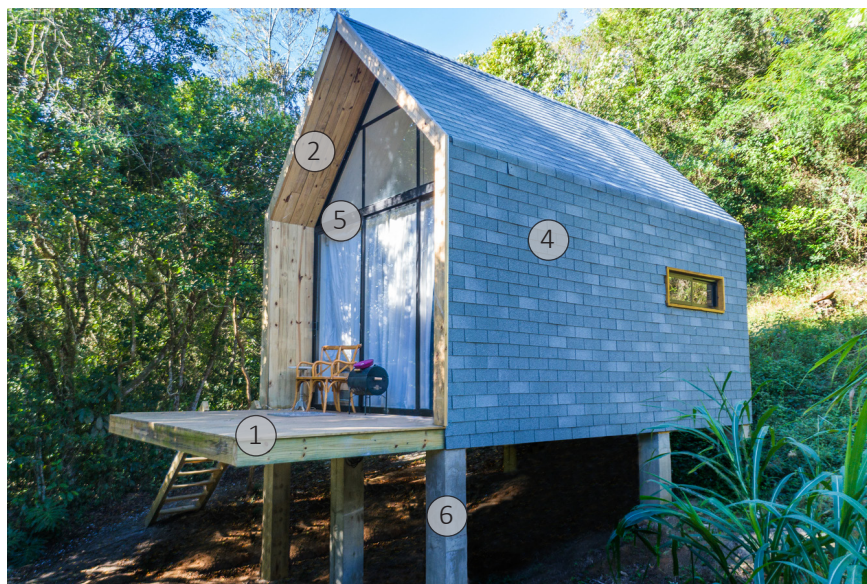
Imagen 151. Tiny house Walden. Fuente: A+R ARQUITETURA, 2020
