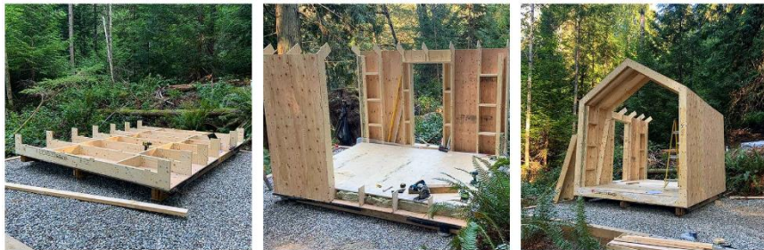
Imagen 34. Madera implementada en estructura de tiny house. Fuente: THE BUNKIE CO, 2024
