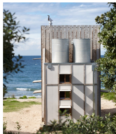
Imagen 85. Sistema de tratamiento de aguas Fuente: Crosson Architects, 2014
