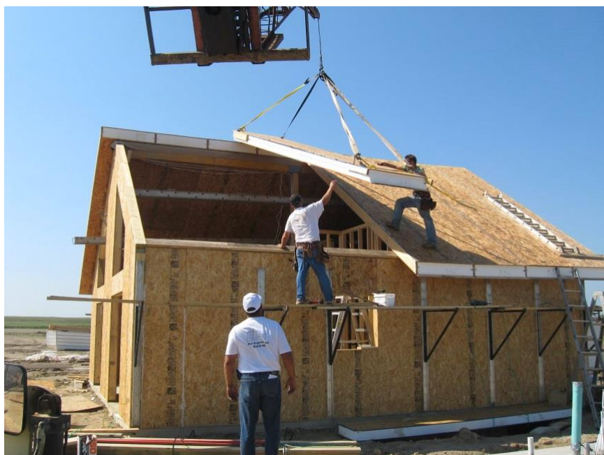
Imagen 32. Instalación de paneles SIP. Fuente: PROPANEL, 2024
