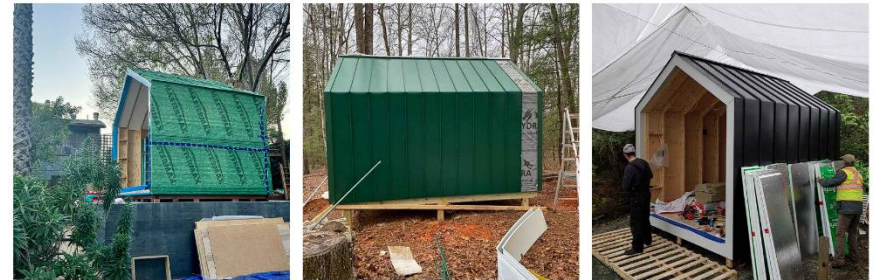
Imagen 35. Recubrimiento de láminas metálicas. Fuente: THE BUNKIE CO, 2024
