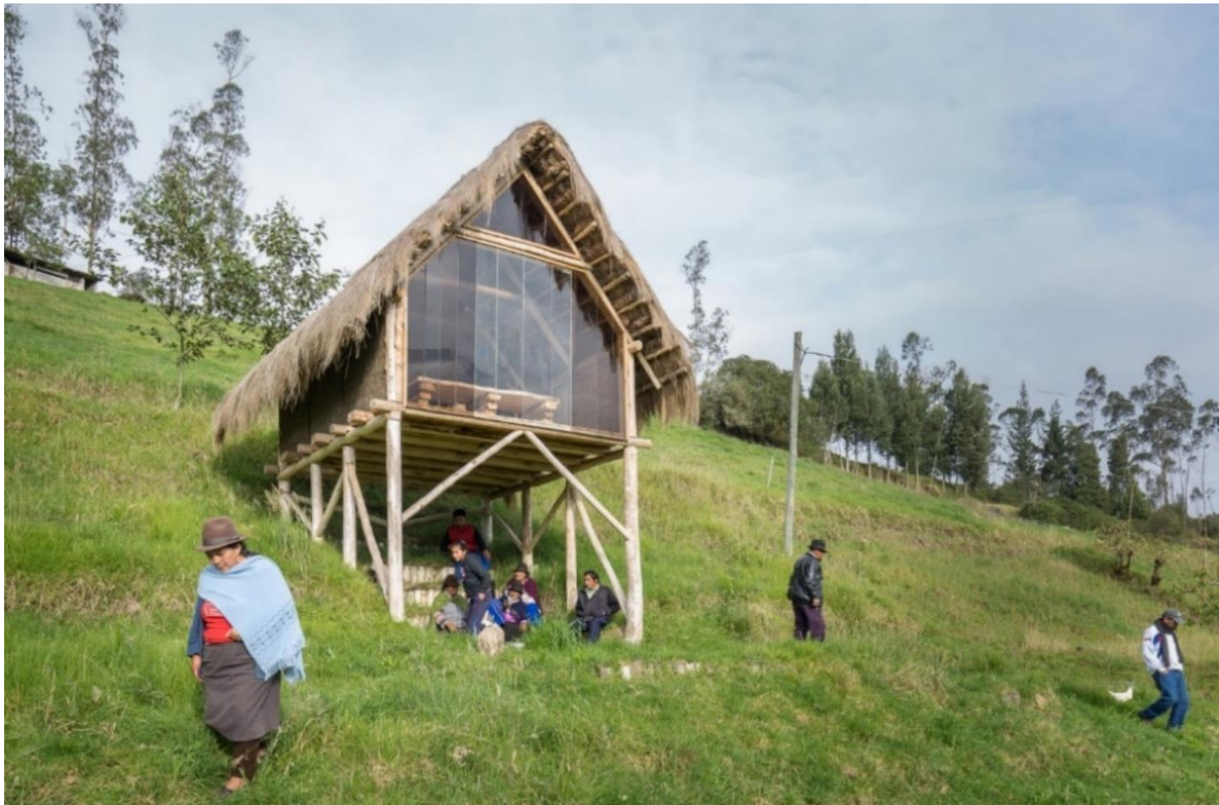
Imagen 111. Kusy Kawsay prototipo de vivienda en guadua y bahareque diseñado por el grupo de arquitectos AL BORDE + UTI – Universidad Tecnológica Indoamérica + David Guambo Fuente: JAG studio, 2020
