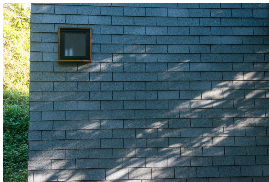
Imagen 153. Materialidad en fachada. Fuente: A+R ARQUITETURA, 2020
