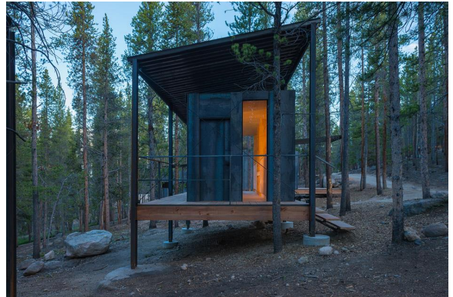
Imagen 14. Tiny houses para centro de educación en bosque de las Rocky Mountains. Denver, Colorado. Fuente: DETAIL ARCHITECTURE, 2017
