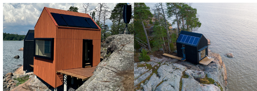
Imagen 70. Implementación de paneles solares en cubiertas. Fuente: Majamaja, 2024
