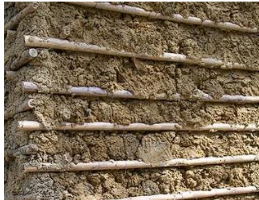
Imagen 105. Muros hechos con Bahareque. Fuente: Structuralia, 2015
