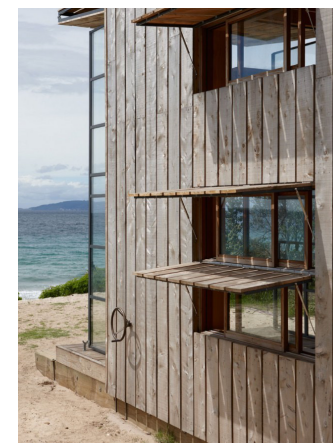
Imagen 86. Contraventanas para controlar el ingreso de luz. Fuente: Crosson Architects, 2014
