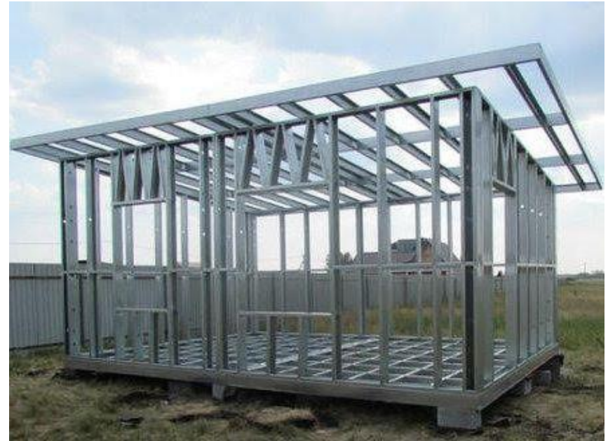
Imagen 31. Esqueleto de tiny house en perfiles metálicos. Fuente: PIONER,2024
