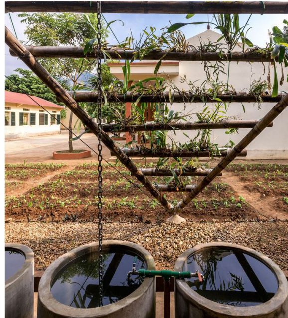
Imagen 54: Cubiertas y fachadas vegetales-H&P arquitectos ase0 2
