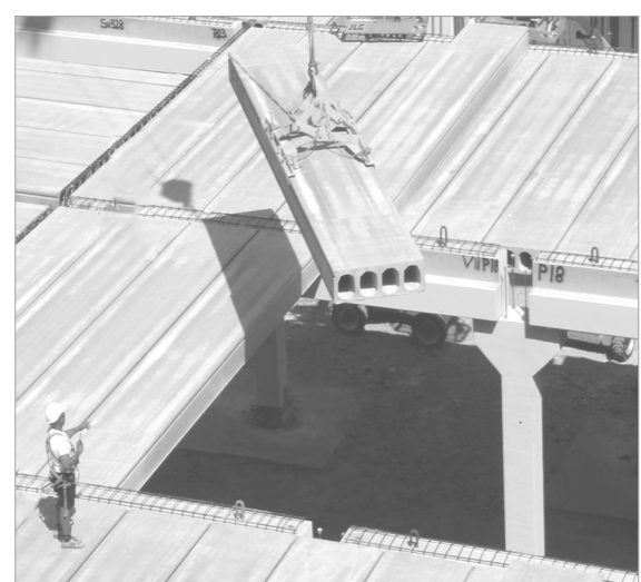
Montaje de un forjado por placas alveolares
