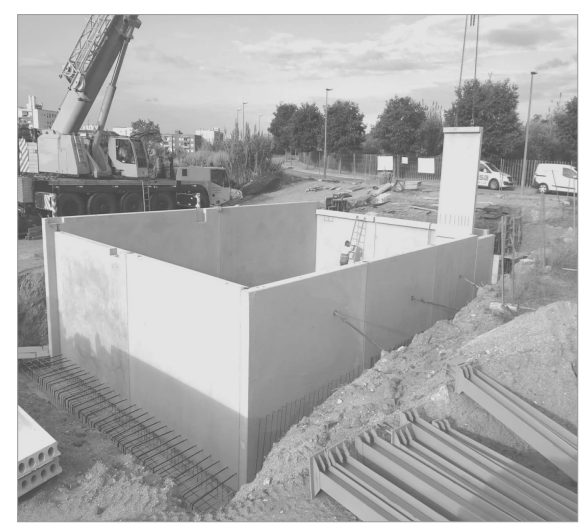
Construcción de un muro macizo de hormigón
