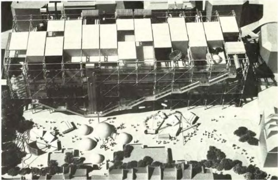
[f39] Vista de la maqueta tras la primera revisión del proyecto. Los ascensores aún se encuentran en el exterior en la fachada este, 1971.
