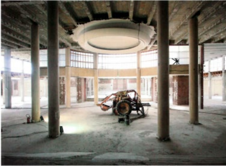
[f61] Vistas de la construcción de la fase 2, 2012.
