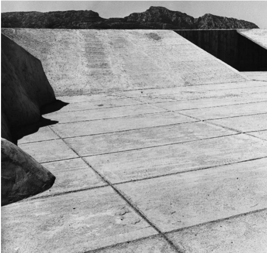
[f6] Terraza de la unidad habitacional de Marsella.
