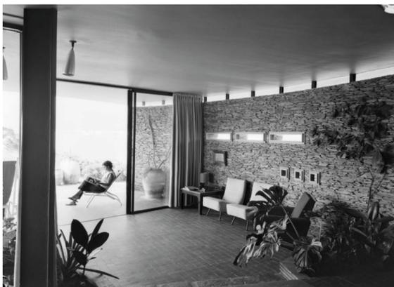
**Figura 17.** Imagen de la independencia muro – cubierta. F. Català-Roca. Arxiu Històric del COAC
