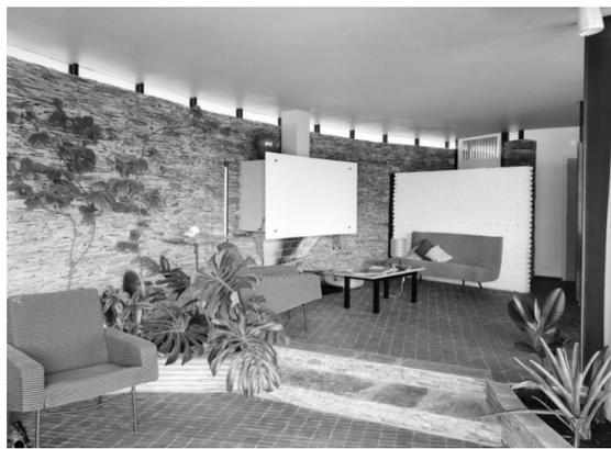
**Figura 18.** Imagen de la independencia muro – cubierta. F. Català-Roca. Arxiu Històric del COAC
