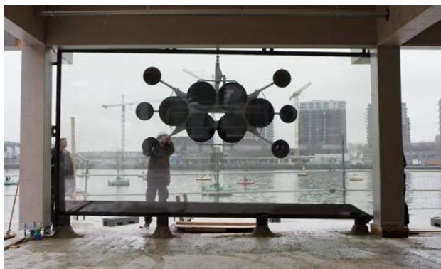
FIG 54_Colocación de vidriera de gran formato
