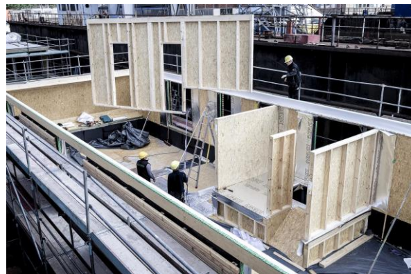
FIG 52_Colocación de la tabiquería Interior
