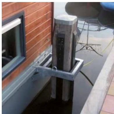
FIG 60_Anclaje en marco guía
