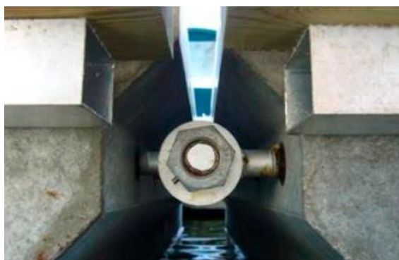
FIG 62_Anclaje entre pontones
