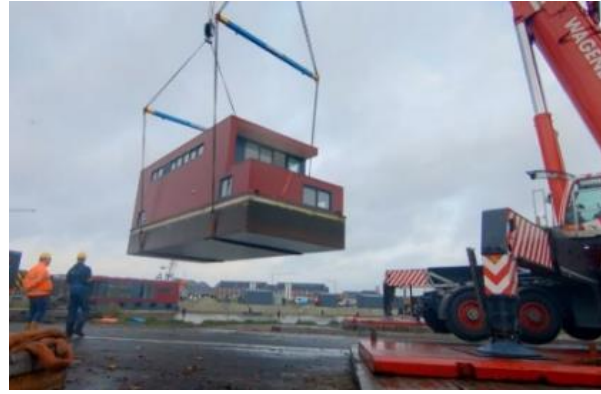
FIG 41_Colocación vivienda prefabricada
