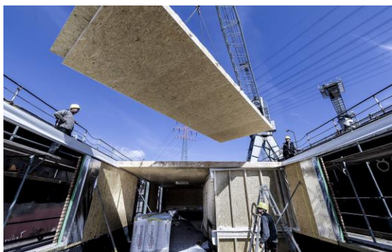
FIG 56_Colocación de forjado en primer piso
