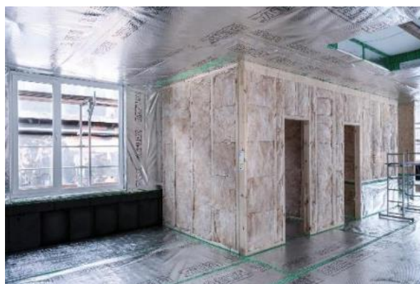
FIG 56_Vista interior de una vivienda flotante en construcción
