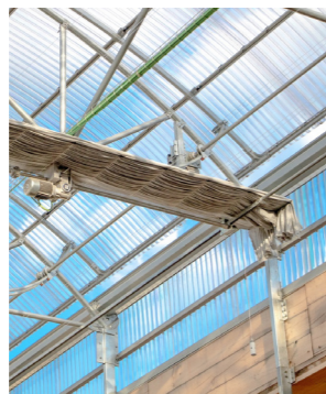
Figura 2.5.16. Cubierta móvil patio térmico.
