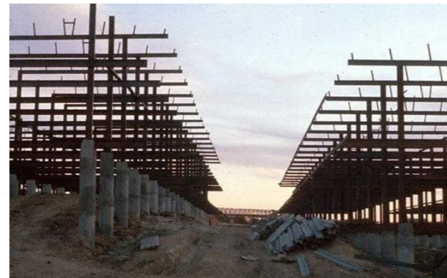
Figura 2.6.16. Imagen estructura y pilotes.
