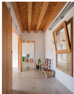
Figura 2.4.14. Viguetas y carpinterías de madera.
