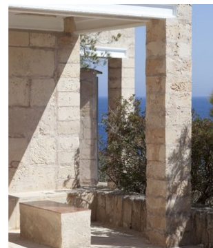
Figura 2.2.4. Muros y pilares de marés.
