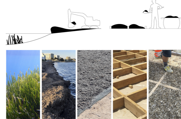
Figura 2.4.15. Aislamiento de cubierta a base de posidonia seca procedente de las playas de la isla.
