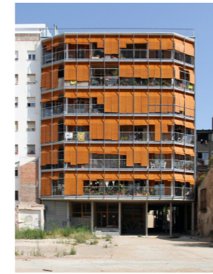
Figura 2.5.20. Fachada sur con protecciones solares.
