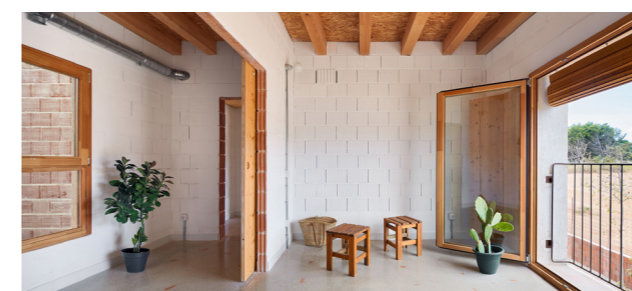
Figura 2.4.23. Instalaciones eléctricas y humos vistas y registrables.
