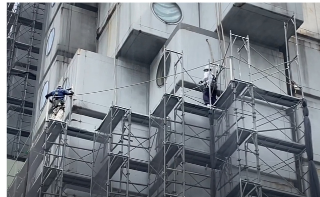
Figura 2.9.18. Imagen proceso de desmontaje.
