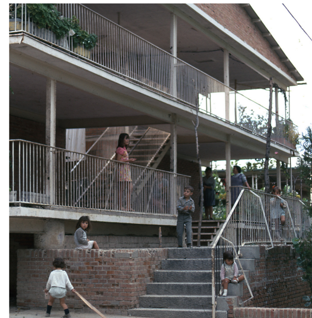
Figura 2.6.10. Imagen escaleras de acceso.
