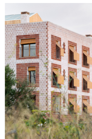
Figura 2.4.17. Fachadas de termoarcilla y persianas de madera recuperables.
