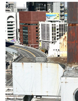
Figura 2.9.24. Estado actual de deterioro.
