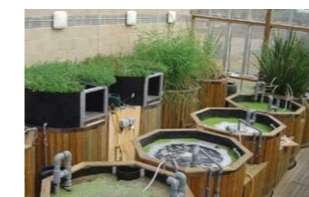
Figura 2.7.19. Imagen depuradora de algas.
