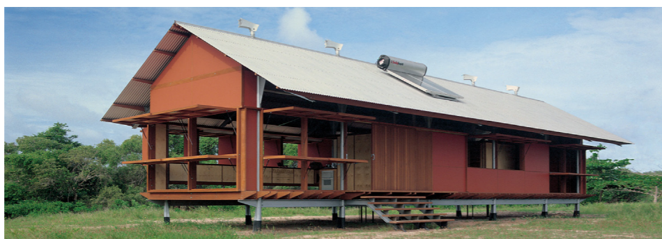
Figura 2.3.5. Imagen exterior de contacto con el entorno.
