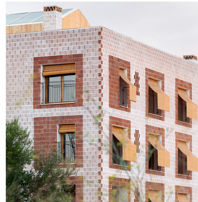
Figura 2.4.17. Fachadas de termoarcilla y persianas de madera recuperables.
