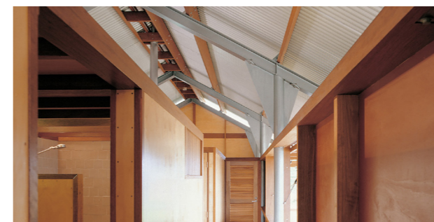
Figura 2.3.10. Imagen estructura atornillada y cerramientos de madera.
