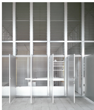
Figura 2.1.14. Detalle fachada este con baño.
