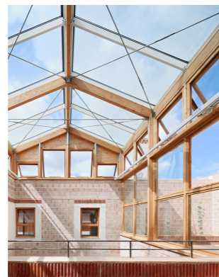
Figura 2.4.12. Cubierto patio climático con carpintería de madera.
