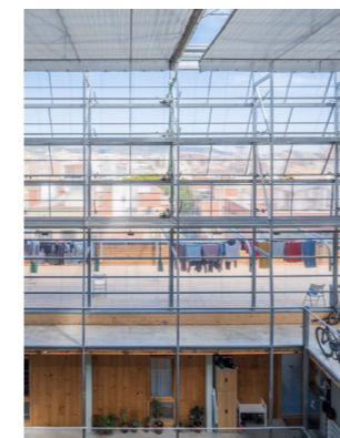
Figura 2.5.23. Cubierta móvil patio térmico.
