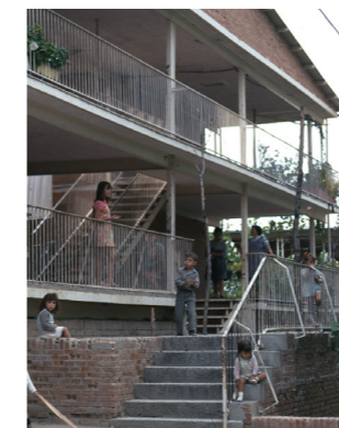
Figura 2.6.10. Imagen escaleras de acceso.
