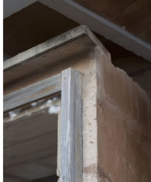
Figura 2.2.14. Detalle protección al agua.
