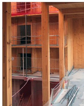
Figura 2.5.17. Estructura de madera sobre base de hormigón.
