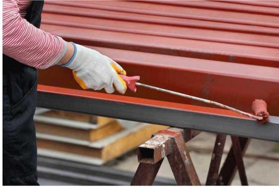
*Ilustración 21: Proceso de imprimación y pintado. Fuente: Bricotex, s.f.*
