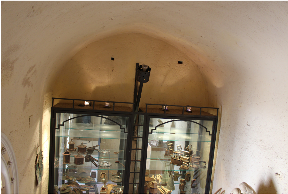
Foto bóveda de cañón planta primera
