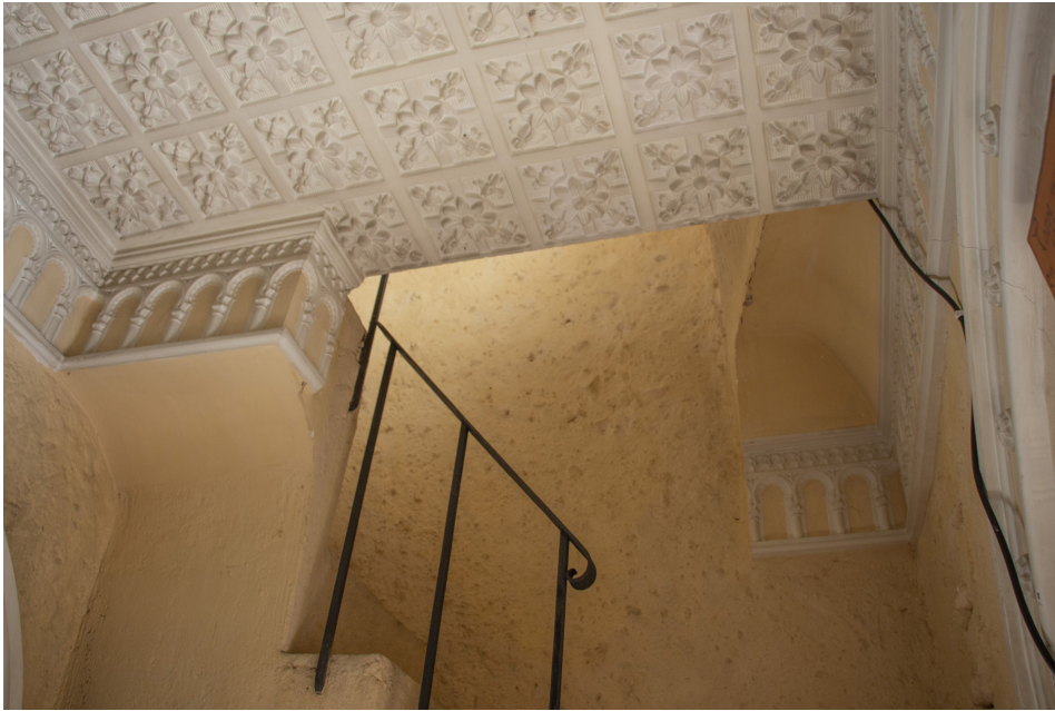
Foto hacia la escalera de planta baja a planta primera
