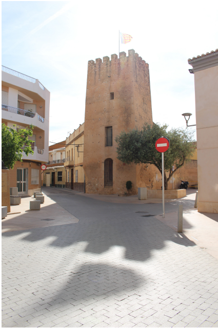
Fachada principal a la plaza de la Torre
