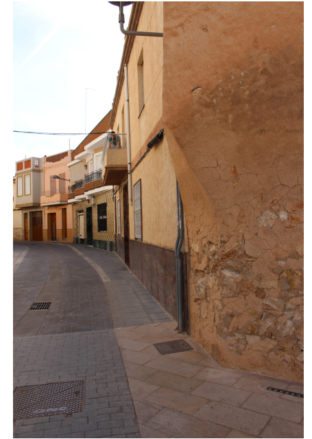
Esquina recortada a la calle de la Torre
