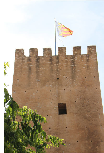
Parte alta de la fachada principal
