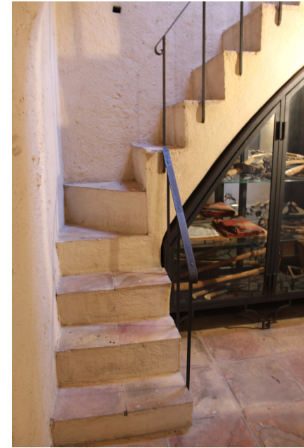
Arranque escalera de planta segunda a cubierta
