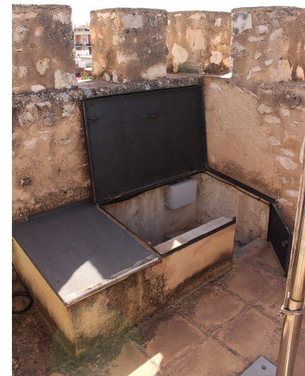
Salida a cubierta
