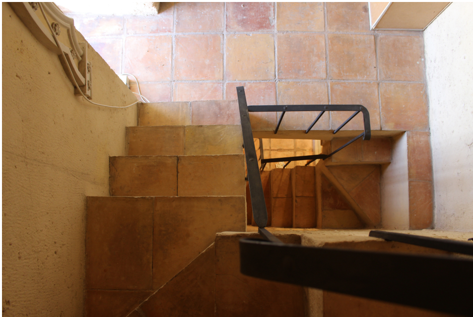
Escalera desde planta segunda
