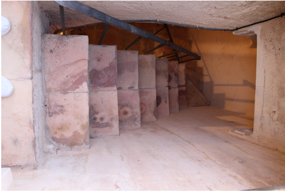
Escalera desde planta segunda a cubierta
