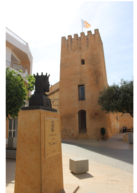
Fachada principal a la plaza de la Torre
