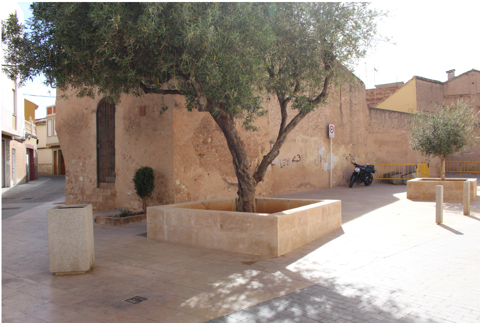
Fachada principal a la plaza de la Torre
