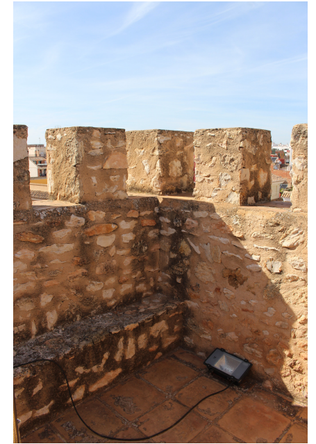
Esquina de la cubierta
