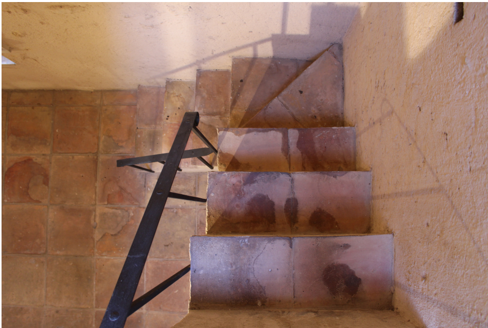
Escalera desde planta segunda a cubierta
