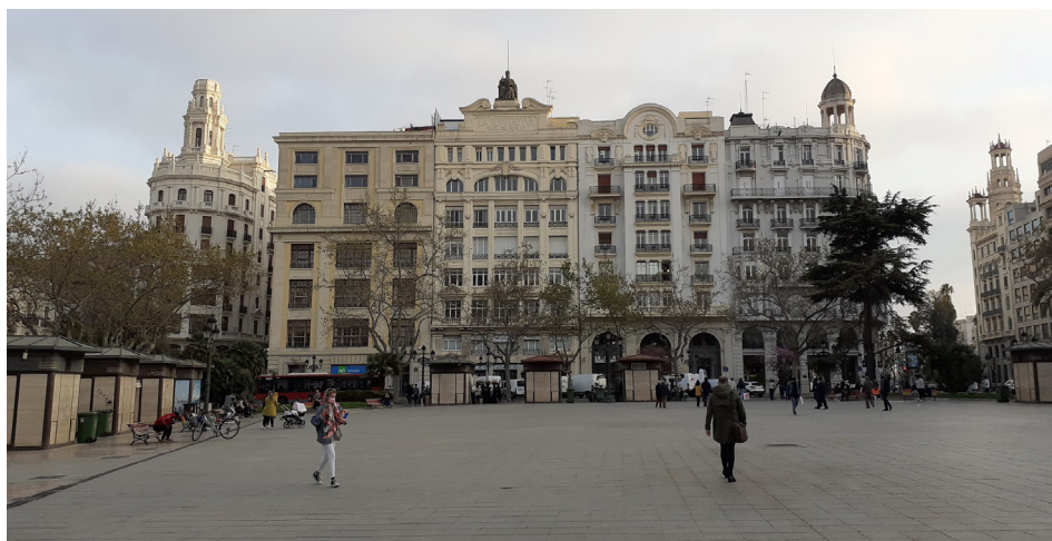
Figura 8. Plaça de l'Ajuntament (València), façana sud
