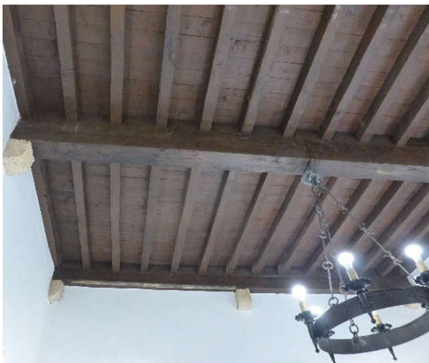
Figura 83. Forjado despacho secretaría
