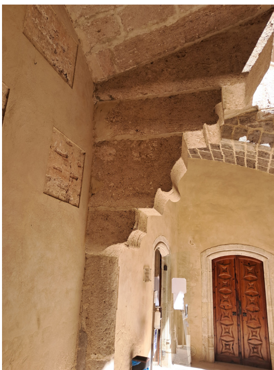
Figura 45. Mensula y pilar galería oeste
