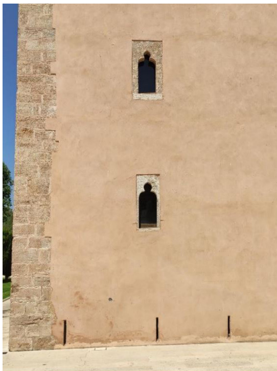
Figura 104. Refuerzo de sillería esquina Sureste
