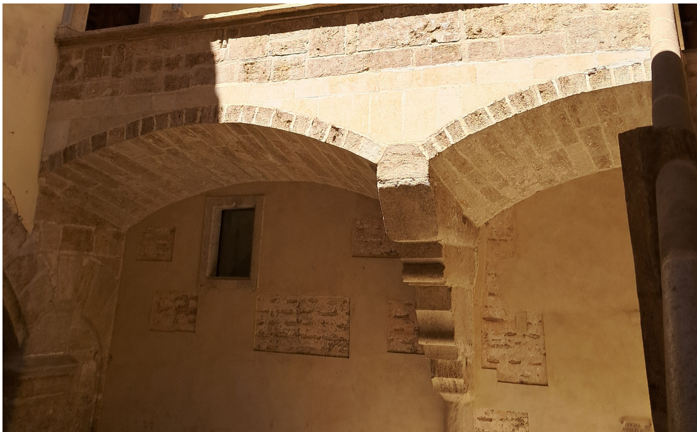
Figura 120. Bóvedas galería oeste
