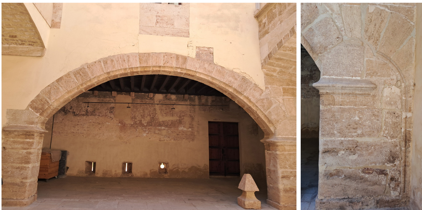
Figura 69. Arco escarzano. Puede apreciarse en el lado derecho los restos del arco de medio punto por el que se accedería al patio desde la crujía sur en el siglo XV
