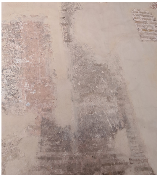
Figura 77. Muro de tapia valenciana en el zaguán de entrada
