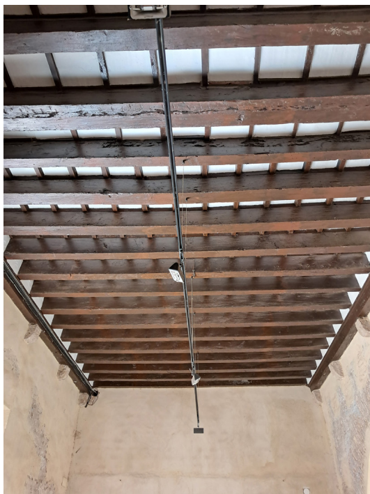
Figura 80. Forjado del zaguán de acceso
