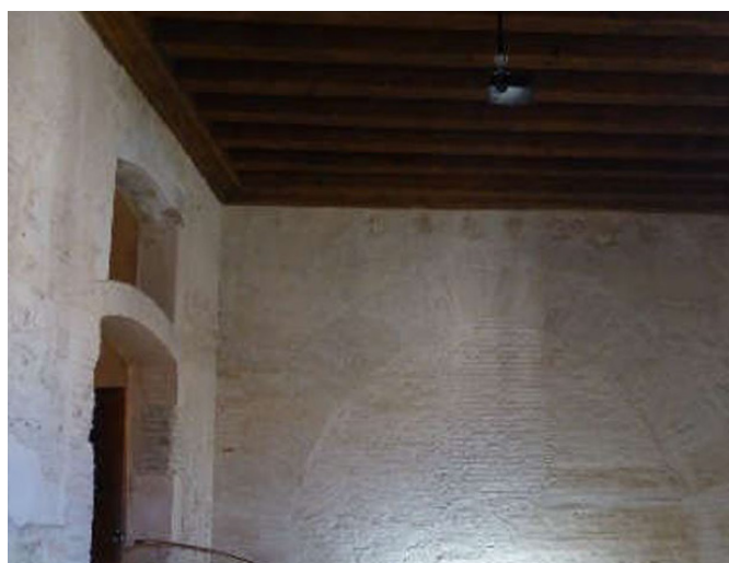
Figura 119. Restos arco diafragmático y arcos de acceso sala de interpretación
