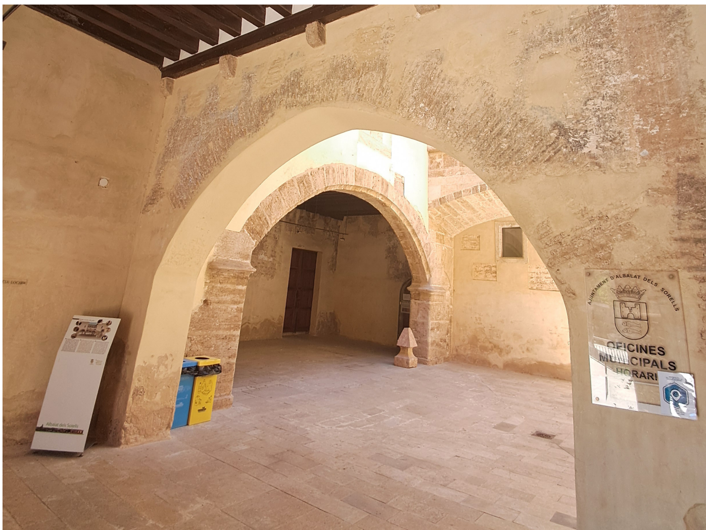
Figura 39. Arco ojival. Acceso al patio
