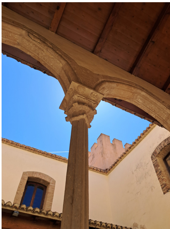
Figura 112 Arcos ojivales Galería Oeste
