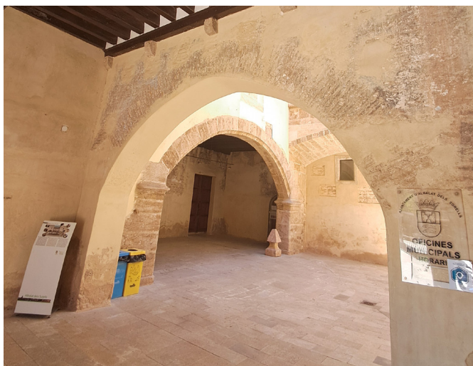
Figura 114. Arco ojival. Acceso al patio
