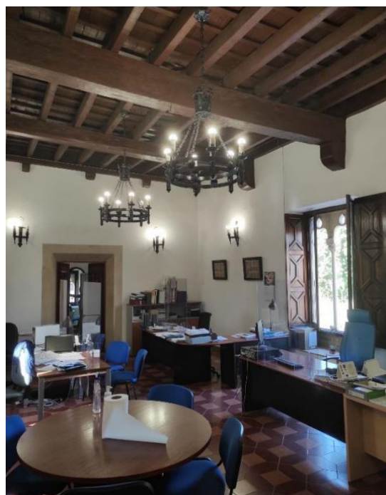
Figura 70. Alfarje de madera en la crujía oeste
