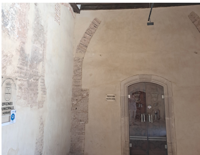
Figura 116. Restos arco ojival zaguán acceso
