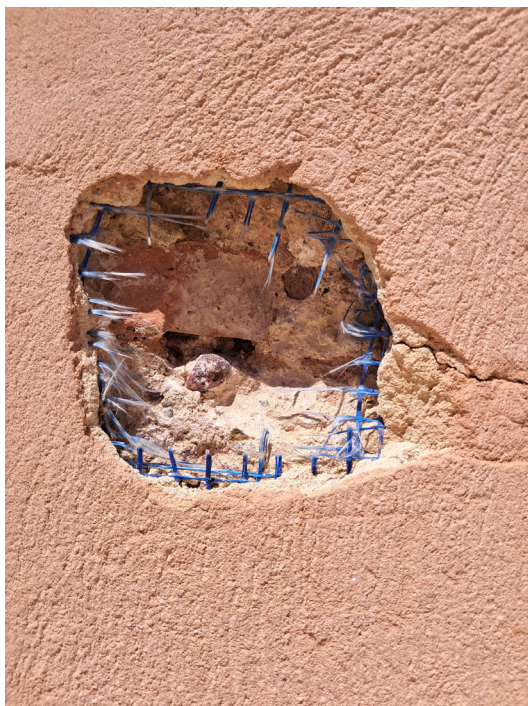
Figura 122. Detalle de las capas de revestimiento de mortero
