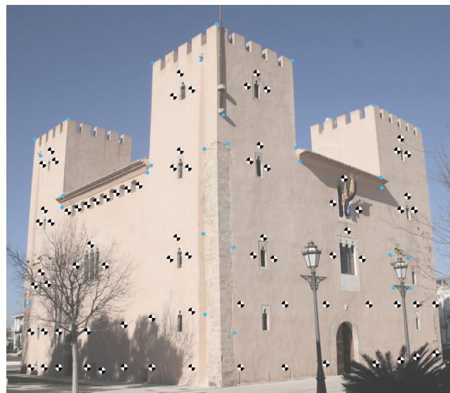
Figura 23. Dianas y puntos reconocibles en las fachadas Este y Sur
