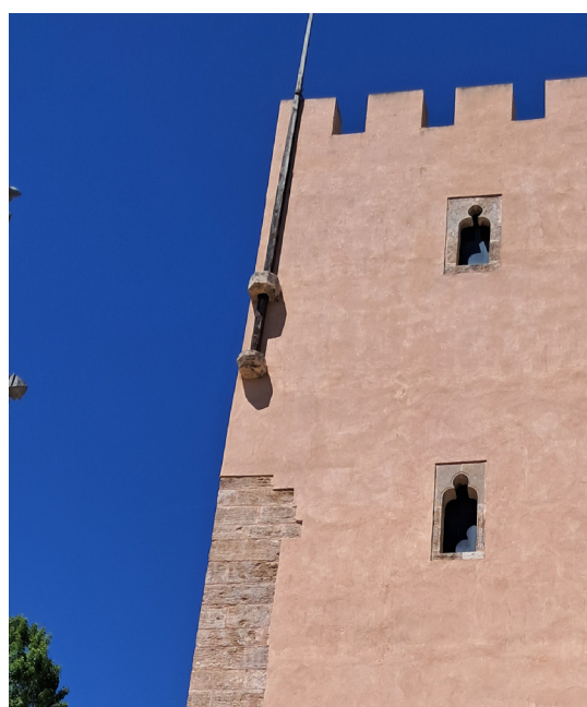
Figura 134 Canes de piedra para el mástil
