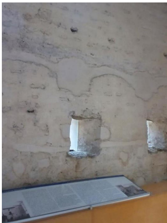
Figura 43. Huella en el muro de viguetas y revoltones
