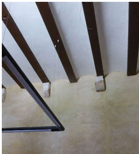
Figura 85. Forjado esquina noreste en planta baja
