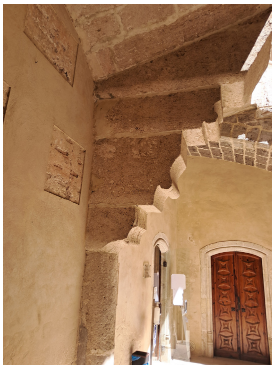
Figura 107. Ménsula y pilar galería oeste
