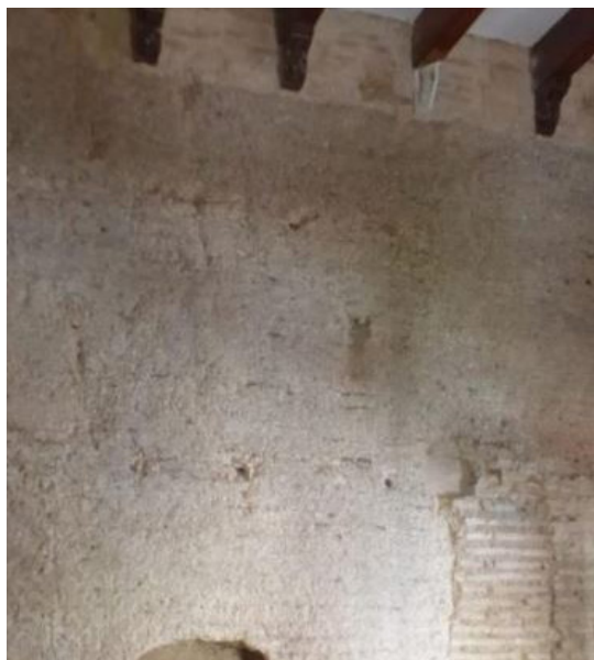
Figura 79. Muro de tapia valenciana en el despacho del alcalde
