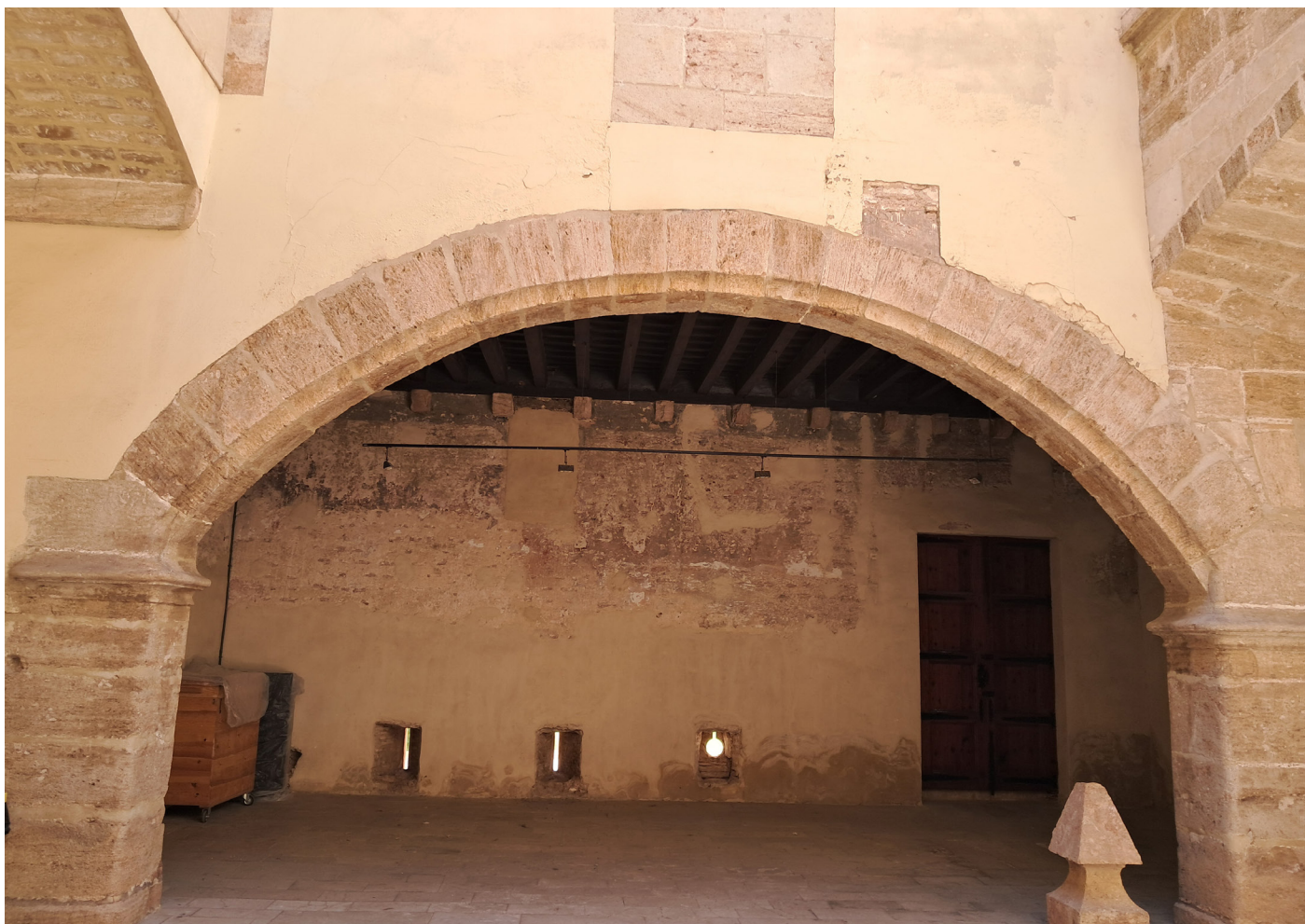
Figura 110. Arco escarzano. Puede apreciarse en el lado derecho los restos del arco de medio punto por el que se accedería al patio desde la crujía sur en el siglo XV
