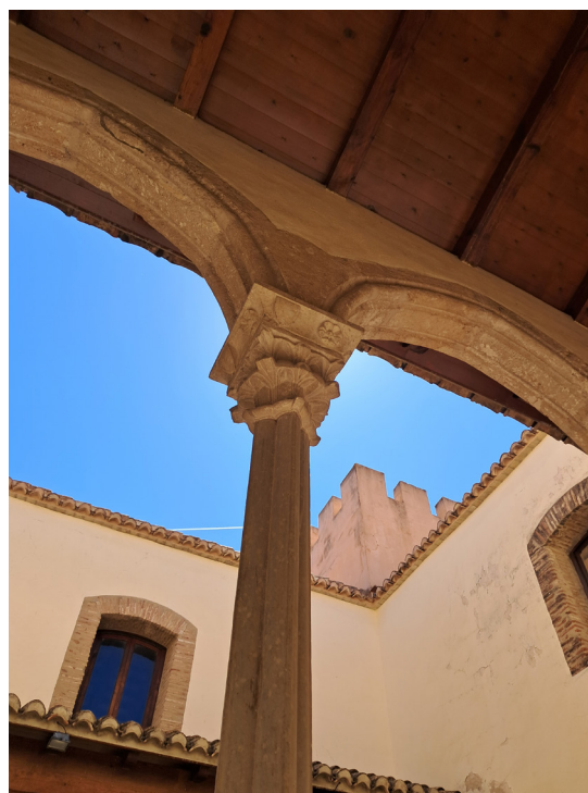
Figura 47. Arcos ojivales Galería Oeste
