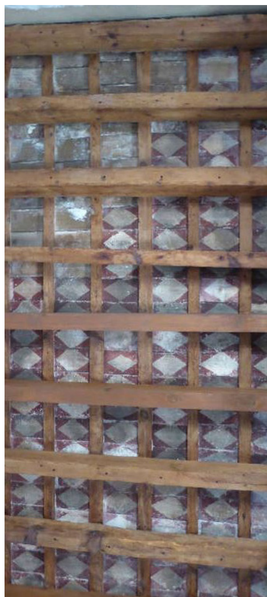
Figura 91. Forjado cubierta de la torre SE
