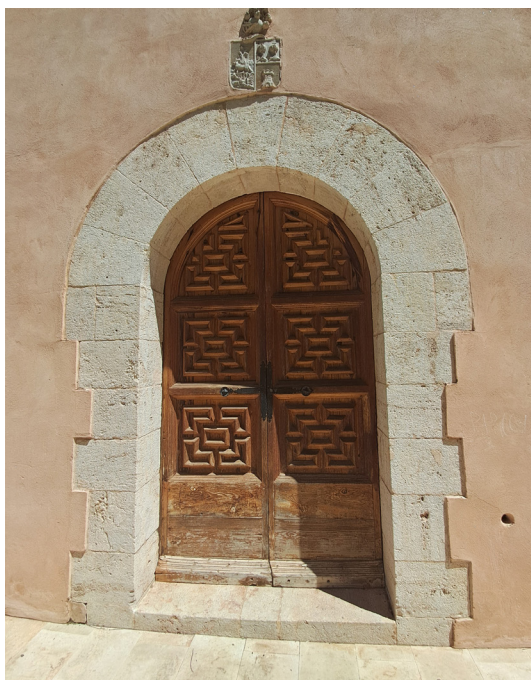
Figura 108. Puerta con arco de medio punto en la fachada sur
