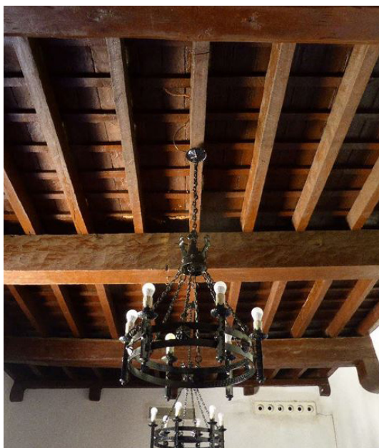
Figura 89. Forjado despachos técnicos
