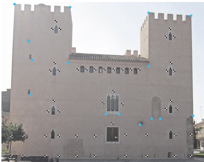
Figura 22. Dianas y puntos reconocibles en la fachada Oeste
