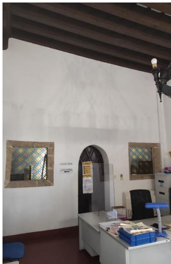
Figura 59. Ventanas y puerta de acceso a la Torre Sureste
