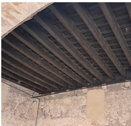
Figura 82. Forjado crujía sur en planta baja
