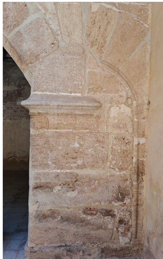
Figura 111. Restos del arco de medio punto
