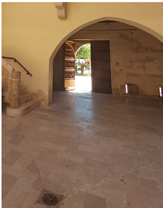
Figura 125. Pavimento del patio
