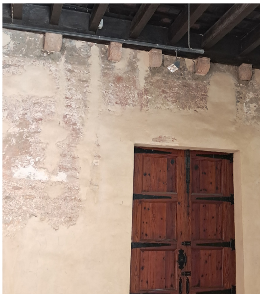
Figura 76. Muro de tapia valenciana en la crujía sur de la planta baja
