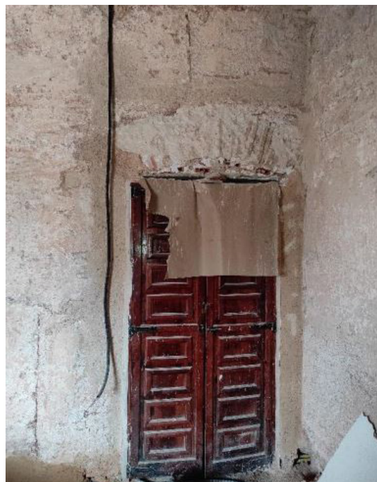
Figura 72. Antigua puerta de acceso a la galería este
