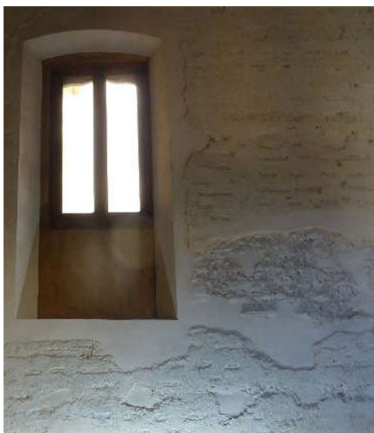
Figura 78. Muro de tapia valenciana en la sala de interpretación
