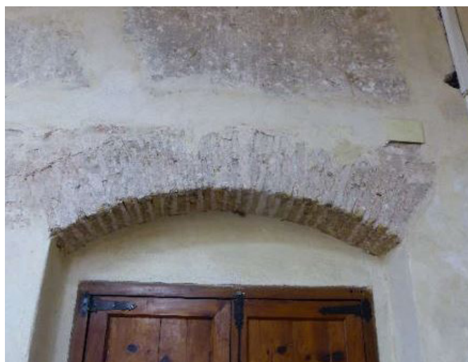
Figura 117. Arco rebajado de dos roscas
