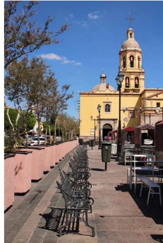
Figura 113: componentes ambientales sin valor patrimonial y comercios ambulantes que obstaculizan el paso. Exconvento de la Santa Cruz. Fuente: fotografía propia. 2023
