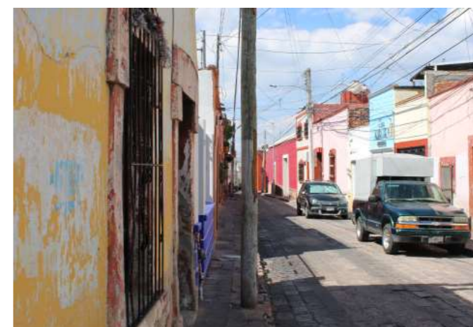
Figuras 116: Cableado aéreo, postes obstaculizando el paso Fuente: fotografía propia, 2023
