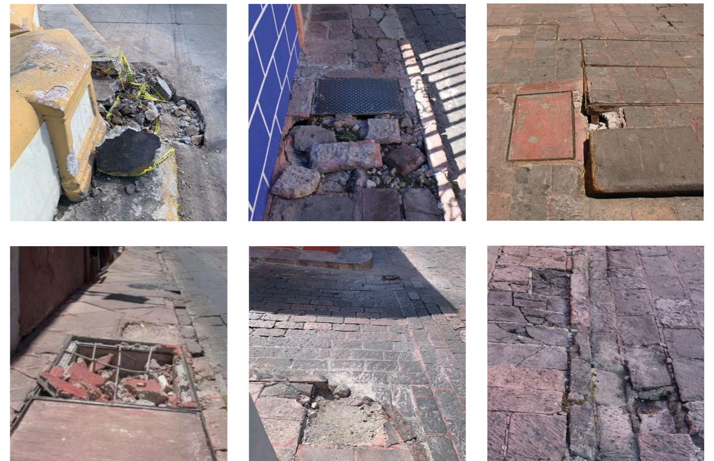
Figura 4: Banquetas (aceras) CHQ Fuente: fotografías propias. 2023
