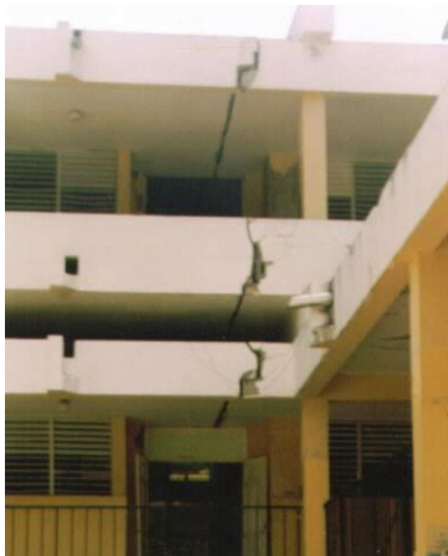
Figura 27: Escuela Reforma – doble losa. Fuente: López & Martínez (2003).
