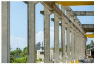
Columnas prefabricadas
