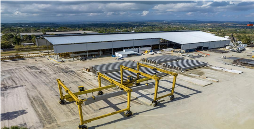
Figura 85: Nueva planta de prefabricados de Acero Estrella. Fuente: Acero Estrella Web (2024).
