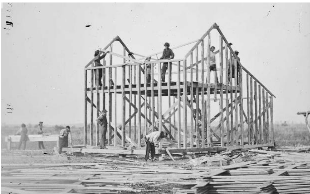
Figura 37: Tipología Balloon Frame. Fuente: The Language of Carpentry, Blog (2024).
