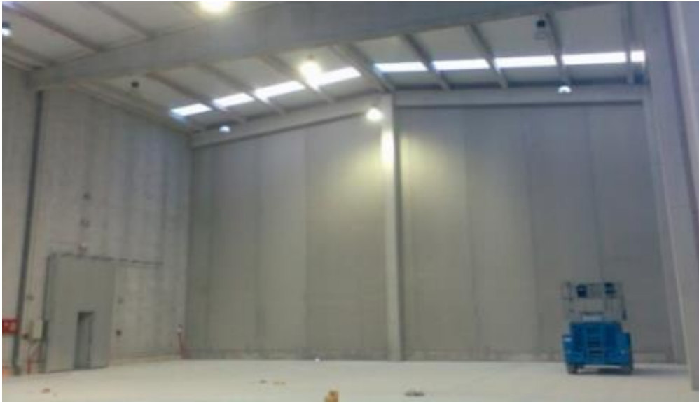
Figura 44: Edificio industrial, Polígono Ind. Santiago-Provasa, Barberá del Vallés (Barcelona) Estructura y cerramientos de hormigón prefabricado. Fuente: Escrig Pérez (2010).
