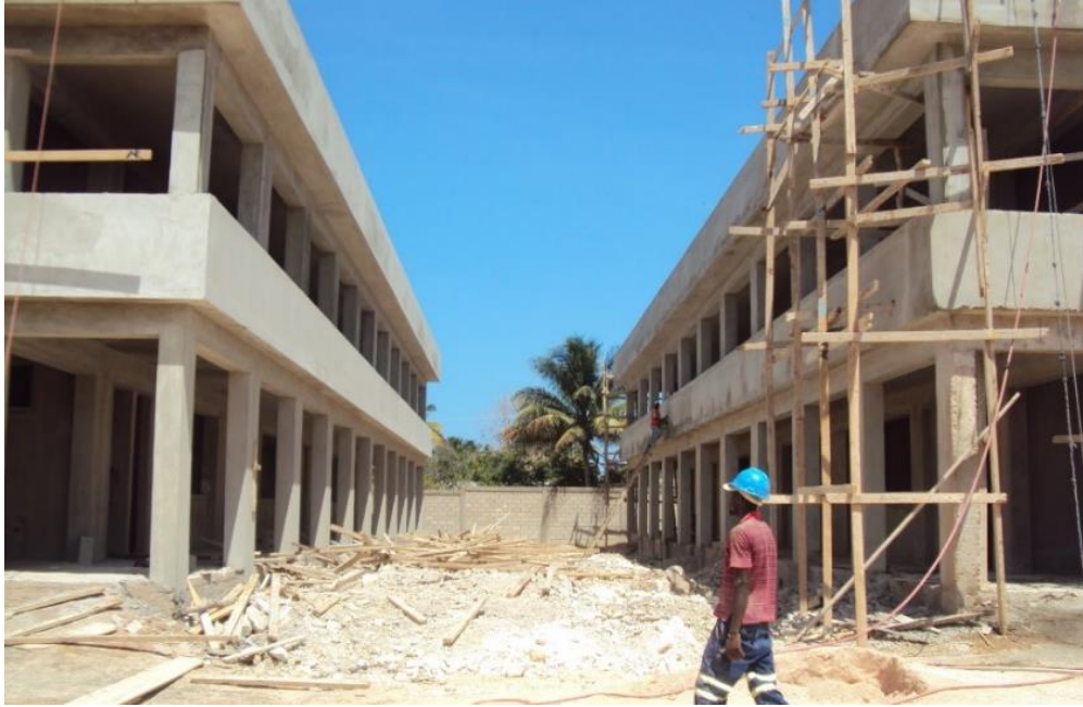
Figura 8: Escuela en proceso de construcción. Fuente: CDN Noticias (2015).
