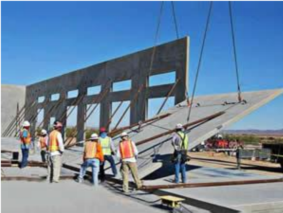
Figura 61: Montaje de panel prefabricado en su sitio. Fuente: Wallpanellines (2024).
