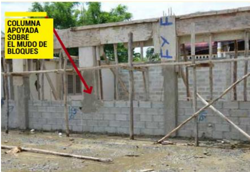
Figura 33: Escuela básica Básima, columna apoyada sobre muro. Fuente: Reyes (2015).
