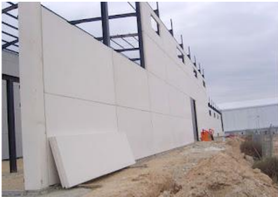
Figura 74: Panel macizo CEPREF de 12. Fuente: Blog de CEPREF (2019).
