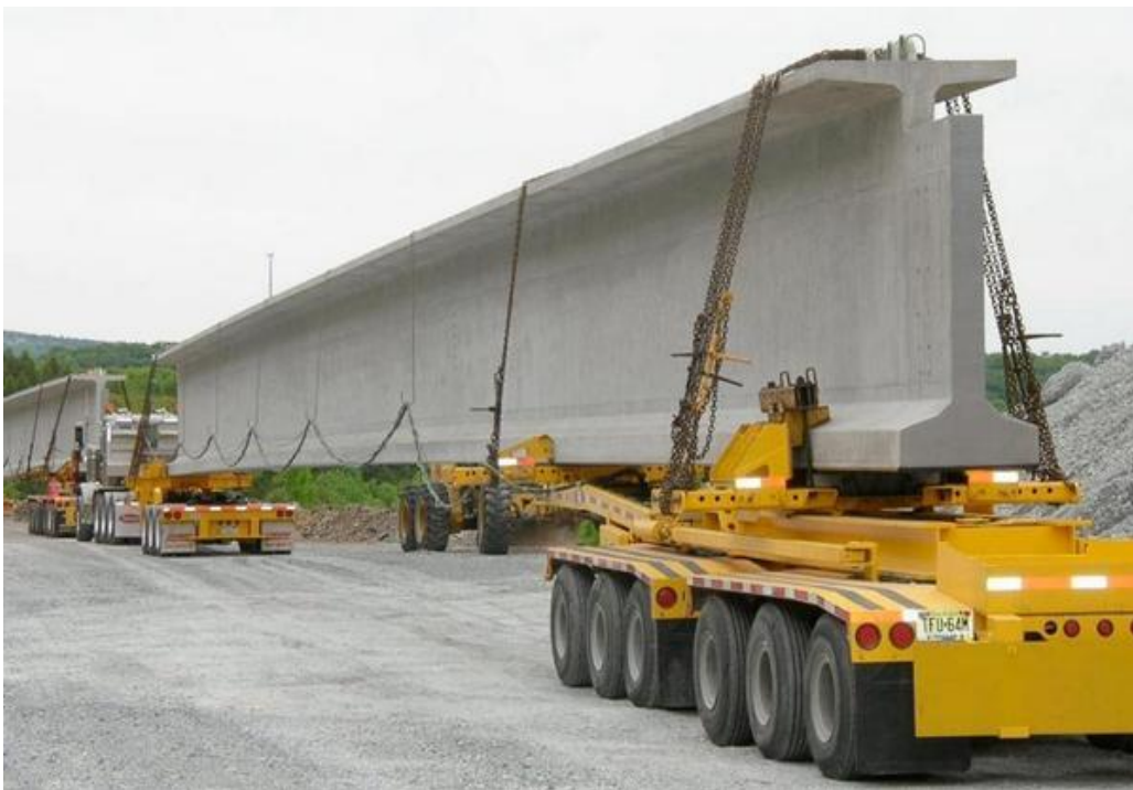
Figura 60: Transporte de grandes vigas de hormigón. Fuente: Poliblogs UPV, autor Victor Yepes Piquera (2013).
