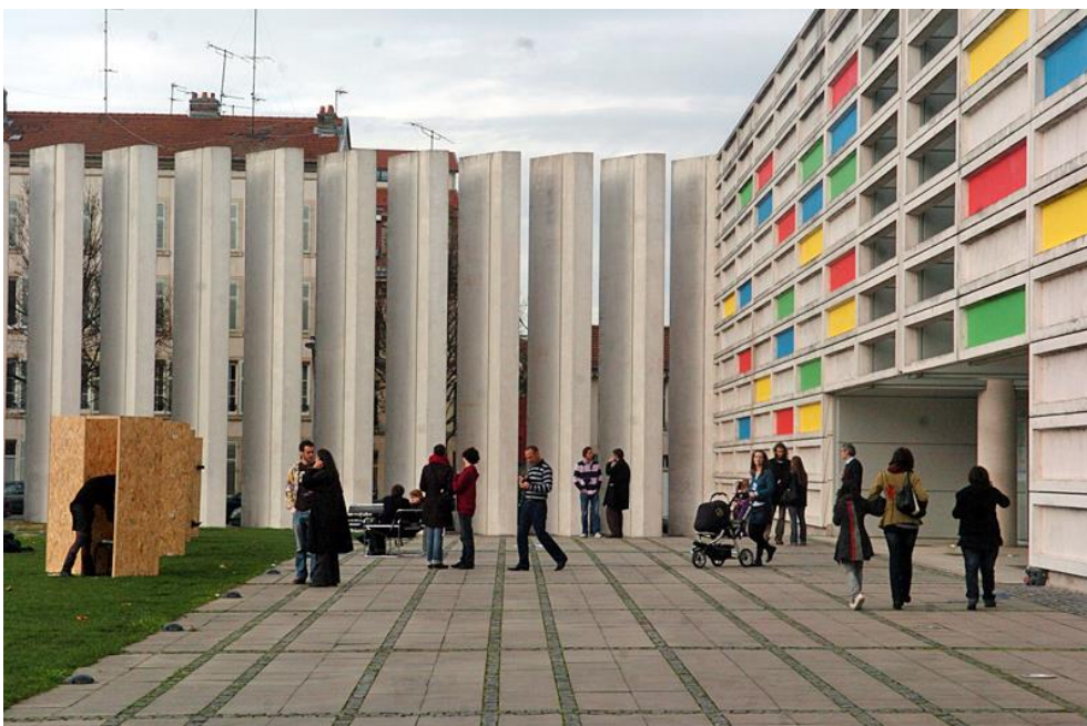
Figura 81: Escuela de Arquitectura de Nancy, Francia. Fuente: Hidden Architecture (2024).
