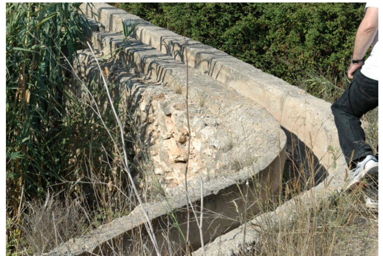
Originalmente, la red de acequias se construía con tierra, piedra labrada o una base de piedras o ripios unidos con mortero, a lo que se aplicaba un determinado tipo de cobertura para evitar pérdidas por filtración.
