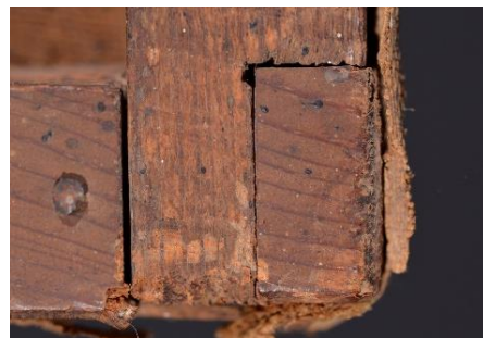
Figura 24. Ensamble español extensible de horquilla abierta
