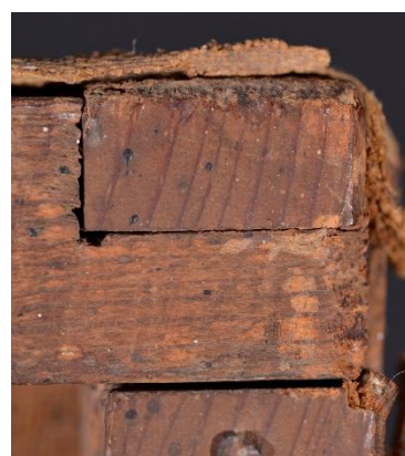
Figura 44. Desgaste de bastidor.
