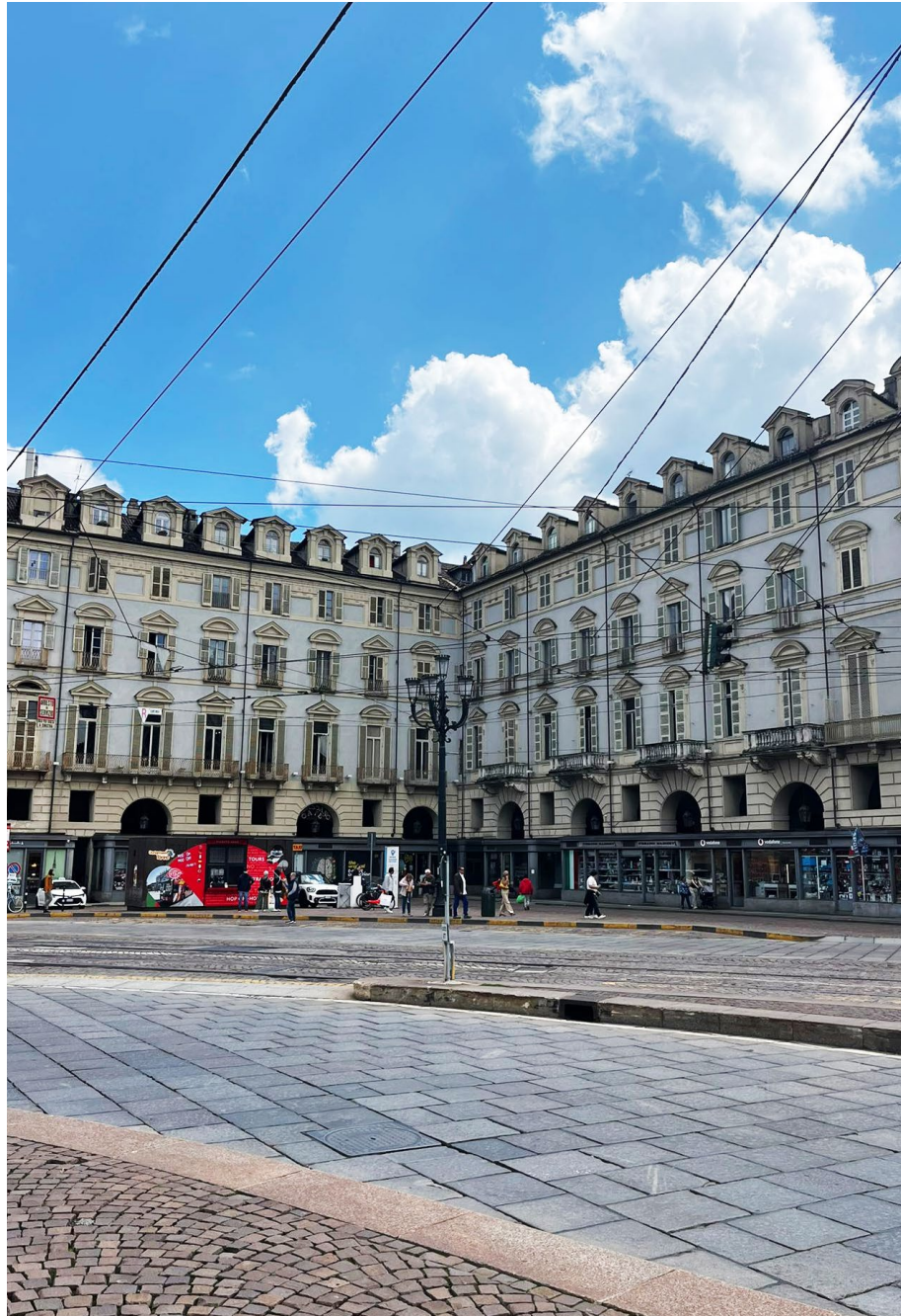
Fig 8.11 Palazzo Nomis di Pollone Tipología: actualmente mixto Fecha de construcción: 1673-75 Arquitecto: Antonio Bettini Estilo: barroco
