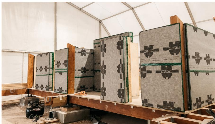
Figura 4.10 Paneles de corcho granulado durante la construcción de la barraca. Fuente: Azalea.
