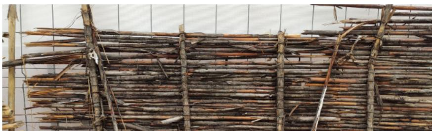
Figura 3.23 Estructura de cañizo durante la rehabilitación de la barraca de Aranda. Fuente: Marcel-Í Rosaleny Gamon
