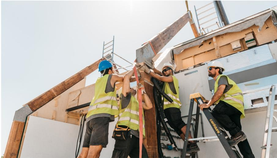
Figura 4.15 Momento constructivo de unión entre viga y pilar, donde se puede observar la placa de anclaje. Fuente: Azalea.
