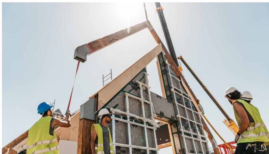
Figura 4.9 Estructura porticada de madera durante el proceso de construcción. Fuente: Azalea.
