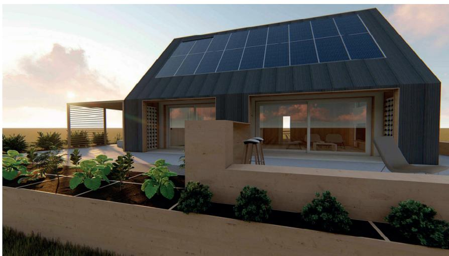
Figura 5.6 Renders del proyecto barraca, representando la doble piel y el sistema de paneles fotovoltaicos. Fuente: Azalea.
