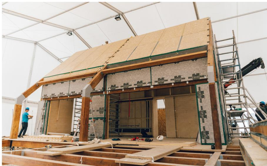
Figura 4.44 Proyecto de la barraca durante la fase de construcción, donde se pueden diferenciar los distintos módulos. Fuente: Azalea.
