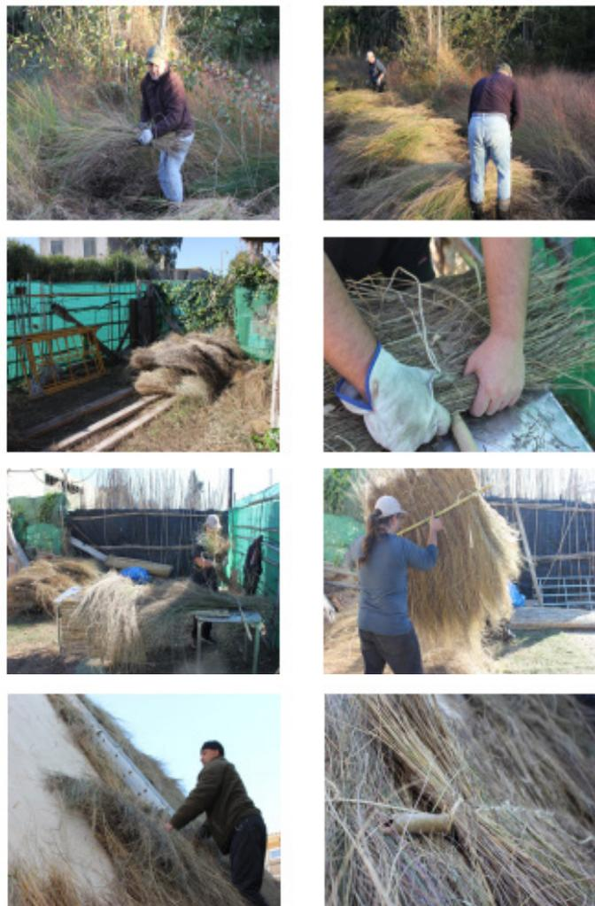
Figura 3.53 Proceso de revestimiento de la cubierta con *borro* durante la rehabilitación de la Barraca del tío Aranda.
