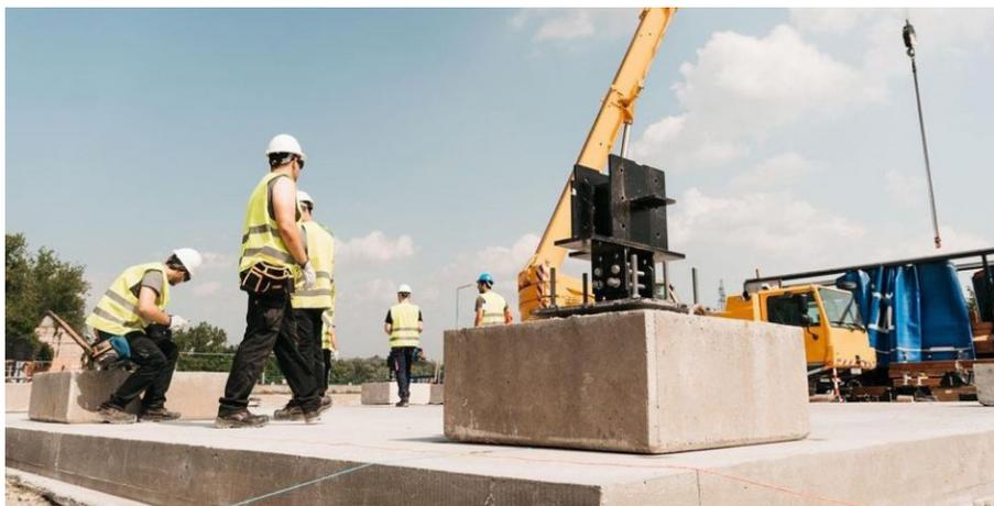
Figura 4.13 Zapatas junto con los herrajes correspondientes para la unión con la estructura del suelo. Fuente: Azalea.
