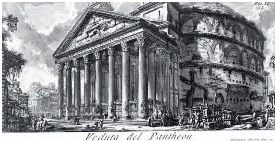
Fig. 4. Giovanni Battista Piranesi (1756, Lám. XIV). Vista del Panteón en la que se observan perfectamente los arcos de descarga embebidos en su muro perimetral.
