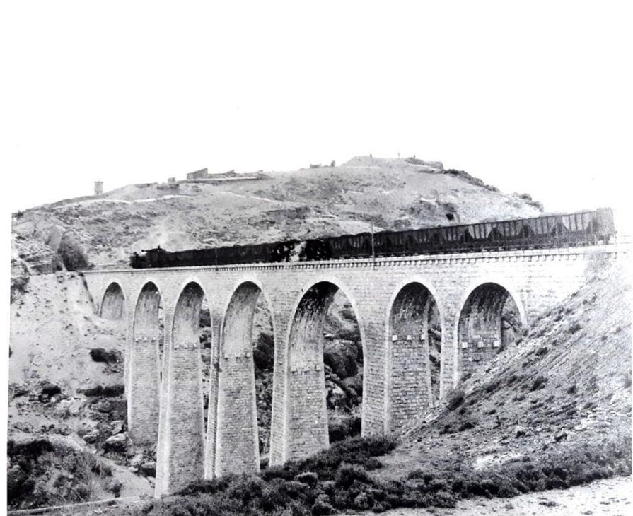
Figura 16. Desde el lado opuesto al pueblo de Albentosa, vista del viaducto por el que circula un tren remolcado por una "Mastodonte" Fuente: Ferrocarril de Sierra Menera
