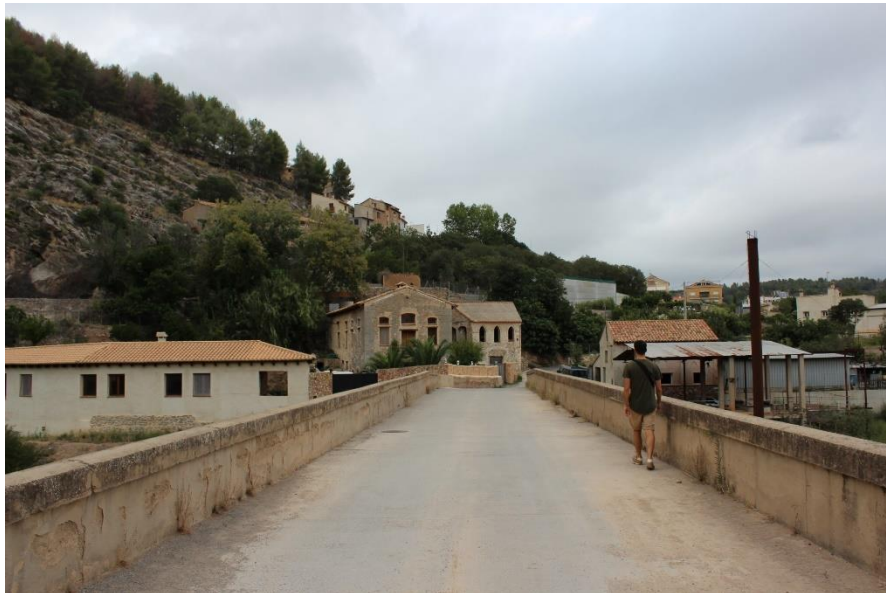
Figura 59. Vista desde el Puente de Navarza Elaboración propia
