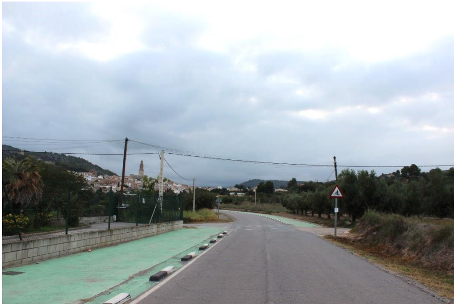
Figura 52. Acceso a Jérica desde la casilla de Santa Bárbara Elaboración propia
