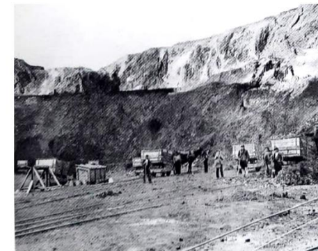
Figura 14. Año 1907: Cantera número 11 de la mina San José. Obsérvese que los mulos remolcaban las vagonetas hasta el cargadero Fuente: Ferrocarril de Sierra Menera
