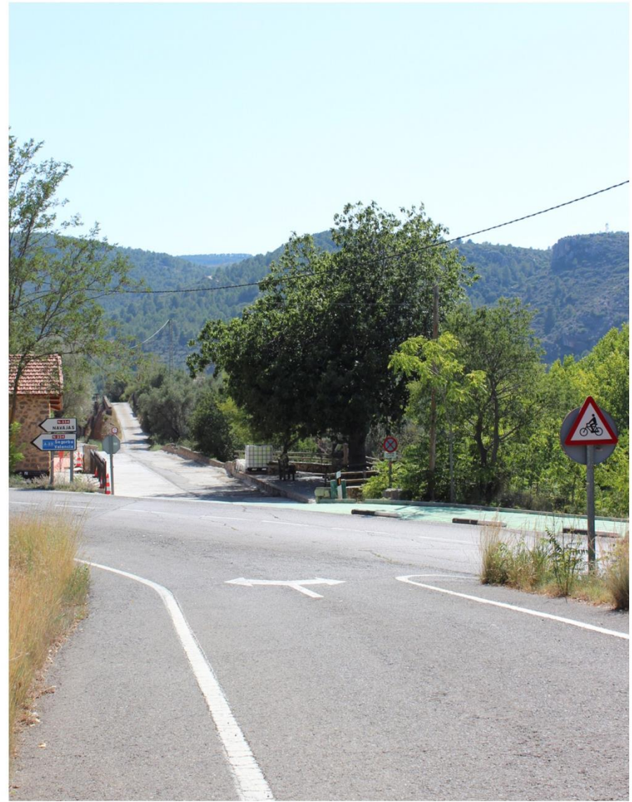
Figura 27. Estado actual del antiguo paso a nivel de la Casilla de Santa Bárbara en Jérica. Elaboración propia
