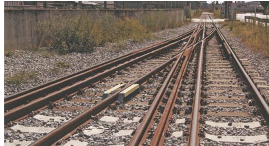
Figura 4. Tramo de vía con 4 carriles y tres anchos de vía distintos, 1.000, 1.435 y 1.668 mm en el Puerto de Barcelona. Fuente: Carles Salmerón, 2011
