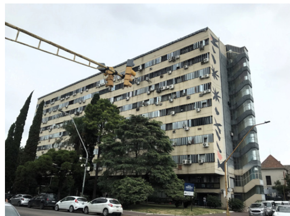
Figura 11. Foto exterior de la esquina Noreste del CAGPSF, 2024. (Foto de la autora).
