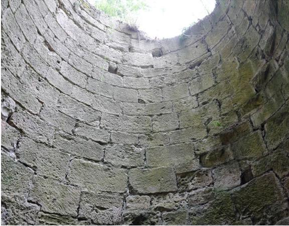
Figura 9. Vista del muro de cerramiento interior del pozo. Se pueden apreciar las hiladas horizontales con distintas alturas. En el encuentro con los restos de los peldaños del caracol, aparecen las irregularidades en la fábrica.
