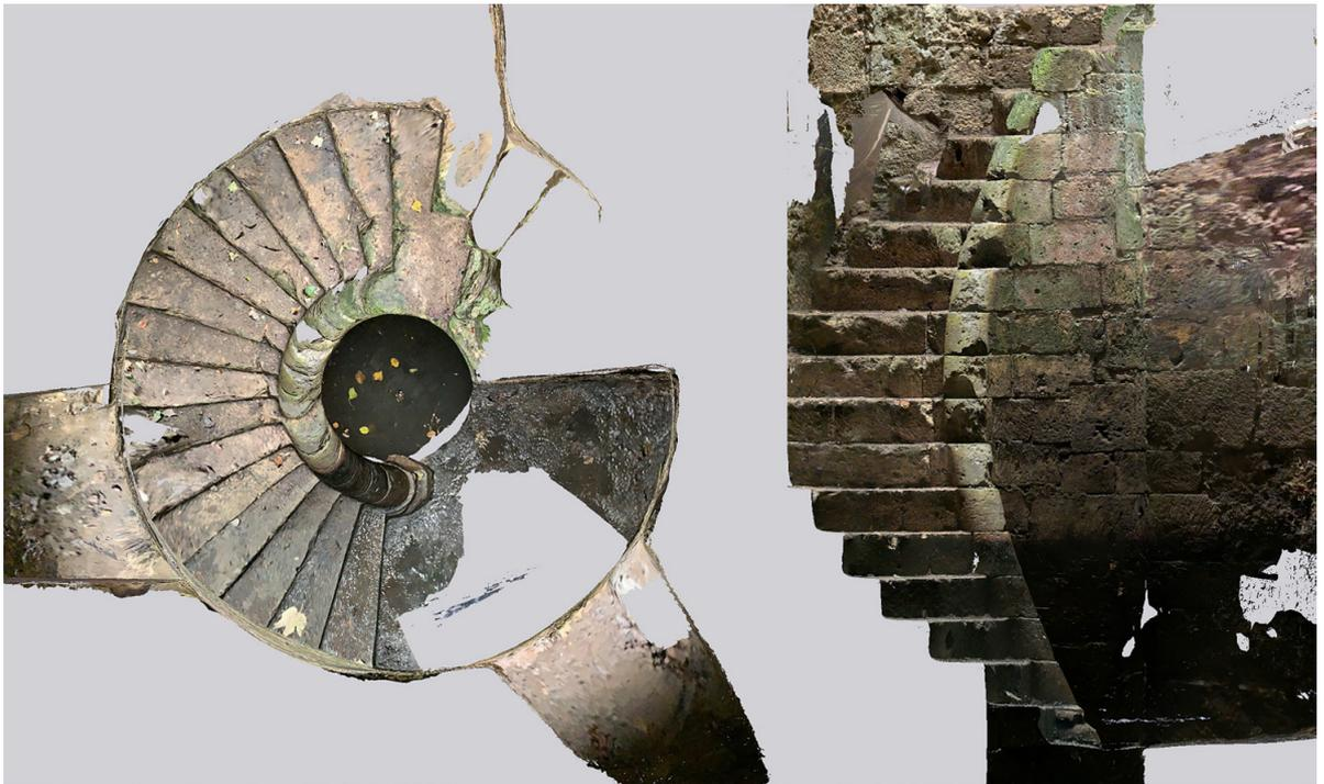
Figura 10: Ortofoto en planta y alzado del caracol con ojo en el interior del Cubo de Aguada. Obtenida del levantamiento con escáner Lidar.
