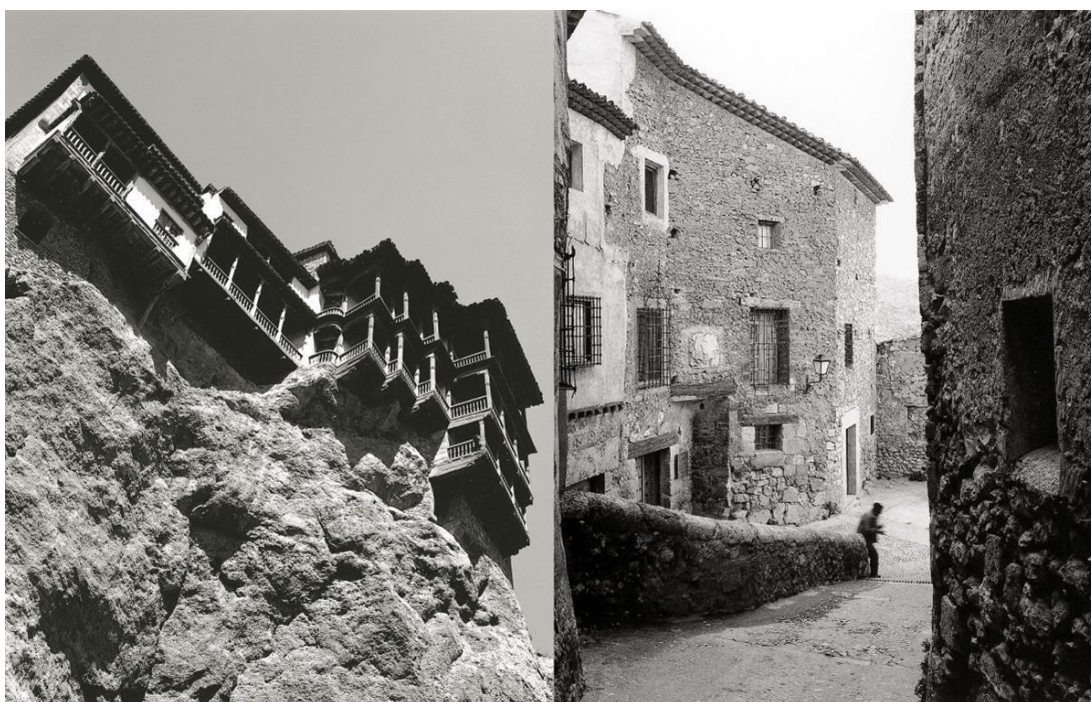
Figura 80. Casas colgadas, desde abajo y desde la puerta.
