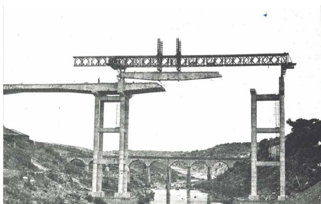
Figura 6. Traslado de una viga prefabricada de hormigón. Puentes de Ahigal (19).
