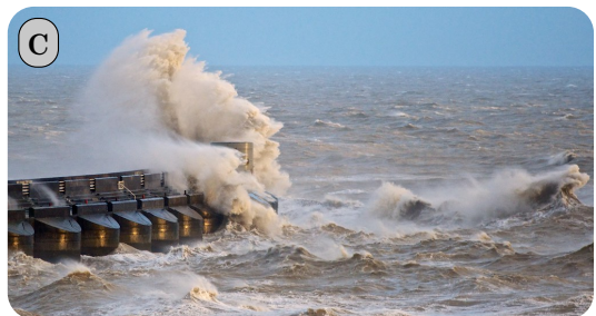
"Rebase de estructuras costeras"
