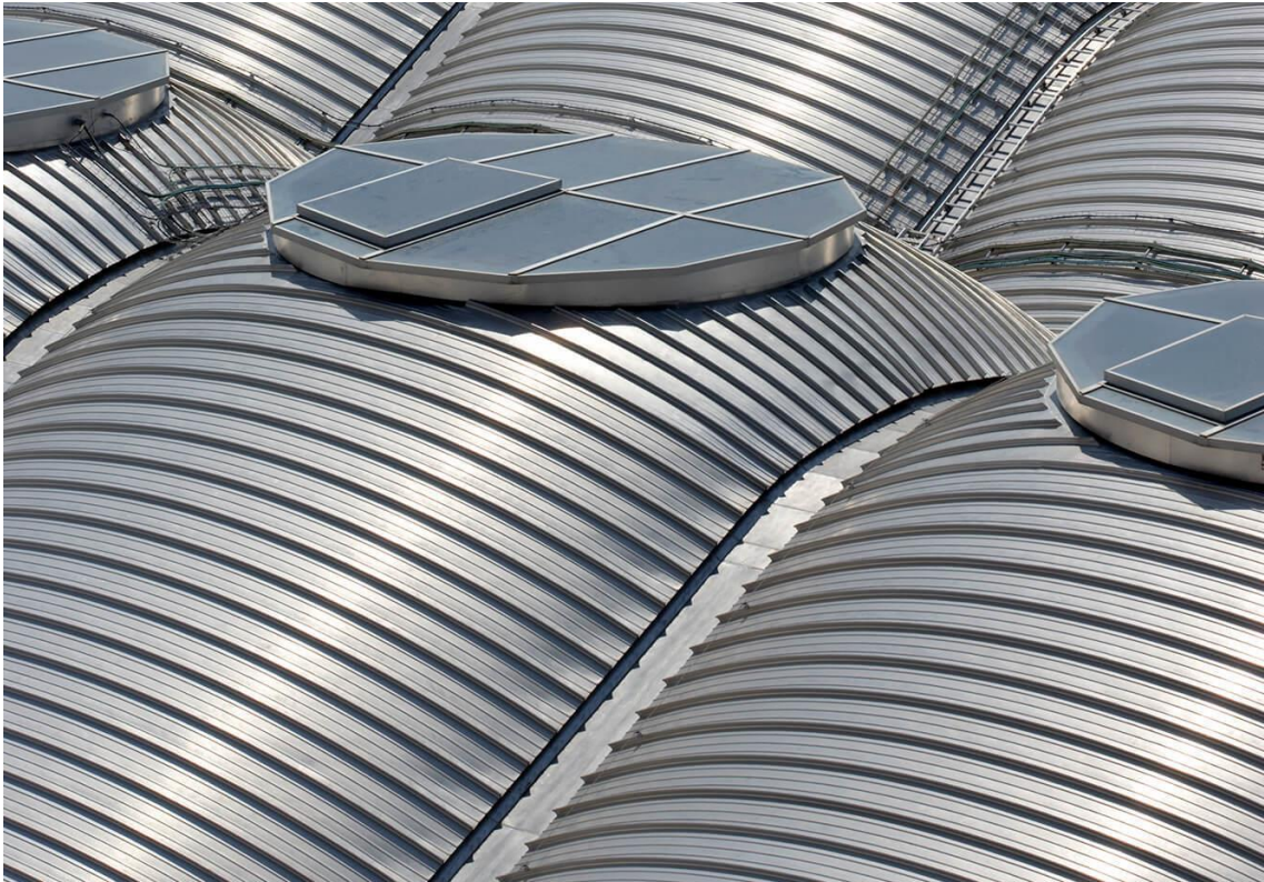
Imagen 34 | Lucernario de la cubierta. (RSHP)
