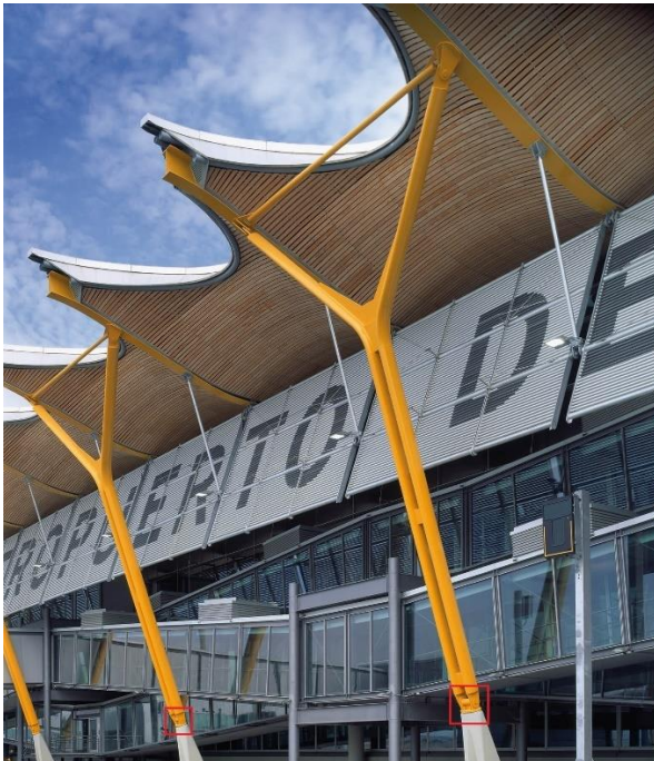
Imagen 102 | Uniones de los pilares en forma de “Y” con los pilares exteriores de hormigón armado. (RSHP)
