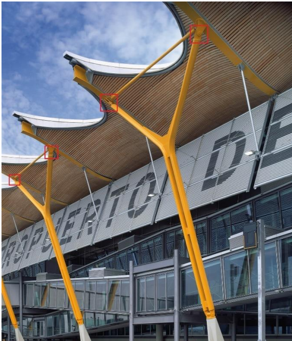
Imagen 105 | Uniones de los pilares en forma de "Y" con las vigas principales. (RSHP)
