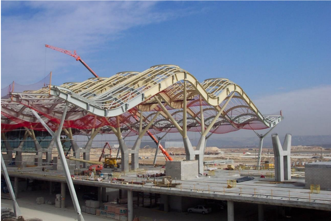
Imagen 25 | Vista exterior del extremo de la terminal en construcción. (Horta Coslada)
