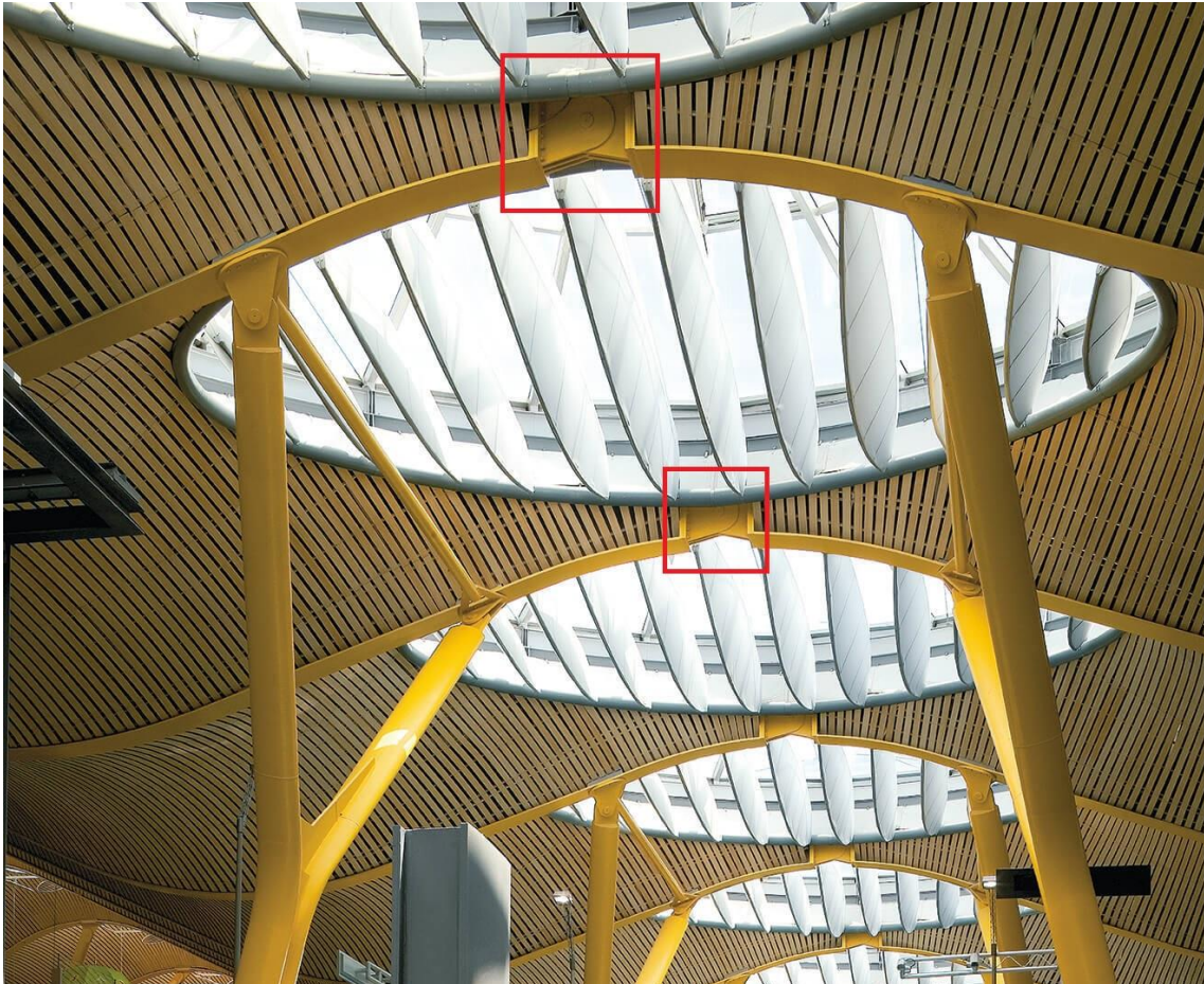
Imagen 111 | Uniones de las vigas principales de diferentes módulos. (RSHF)
