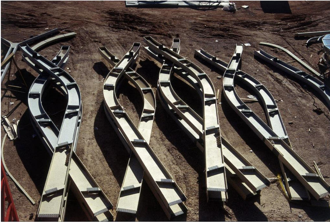
Imagen 27 | Vigas principales. (RSHP)
